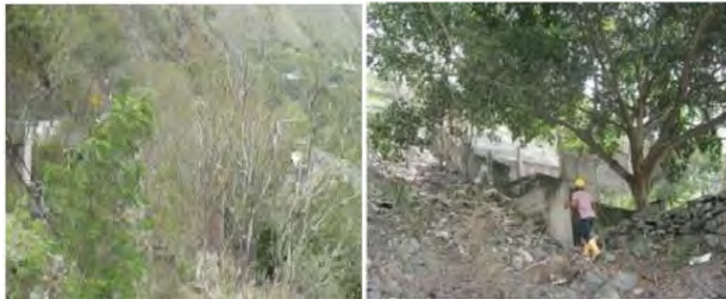
Figura 3 - 78. Infraestructura asociada Zona de emplazamiento de plantas de materiales de construcción en el sitio de disposición final de material sobrante en el predio K60+640 Cisneros-Loboguerrero Margen Derecho
