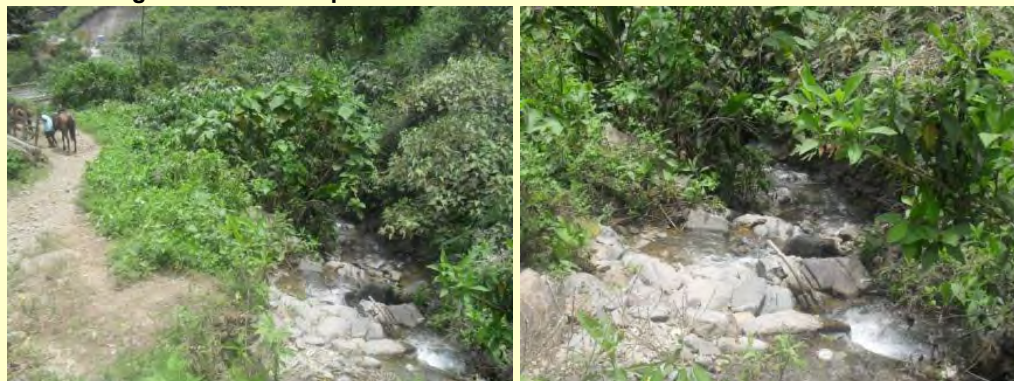
Figura 3 - 109. Margen Derecho e Izquierdo – Quebrada La Reina
