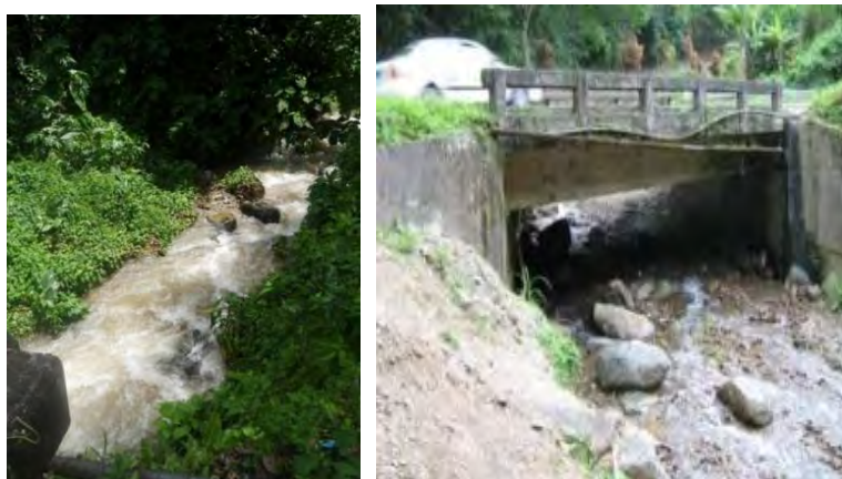
Figura 3 - 55. Drenajes – Zona de retorno La Guinea
