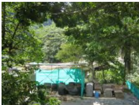
Figura 3 - 68. Infraestructura asociada a la Escuela La Cristalina
