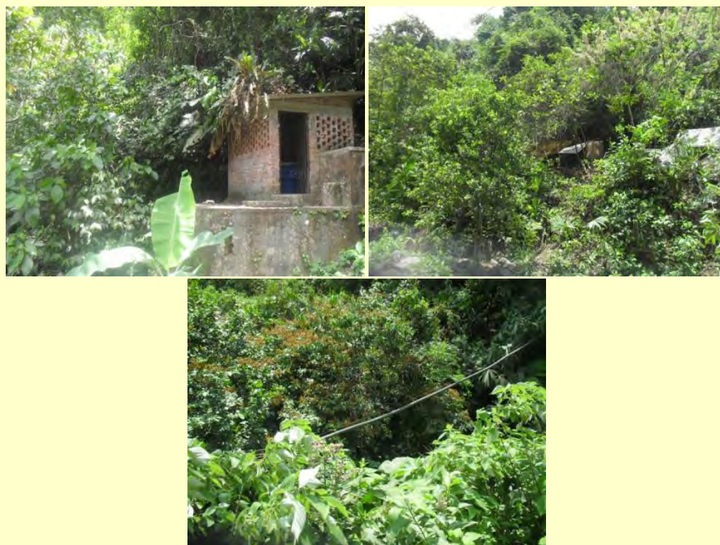
Figura 3 - 105. Tanque de Almacenamiento y Tubería – Acueducto Vereda El Naranjo Quebrada La Reina.
