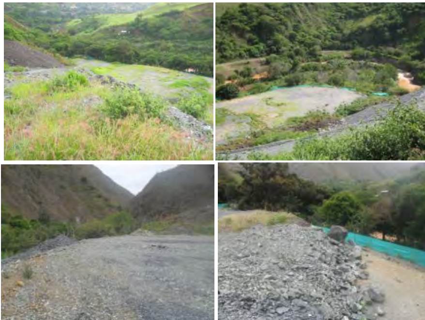
Figura 3 - 71. Sin Uso – Zona de emplazamiento de plantas de materiales de construcción en el sitio de disposición final de material sobrante en el predio K60+640 Cisneros-Loboguerrero Margen Derecho
