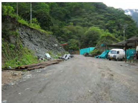
Figura 3 - 58. Área construcción Retorno La Guinea
