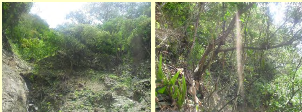
Figura 3 - 102. Vegetación Secundaria – Quebrada NN – K52+840
