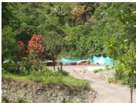
Figura 3 - 66. Sin Cobertura Vegetal – Escuela La Cristalina
