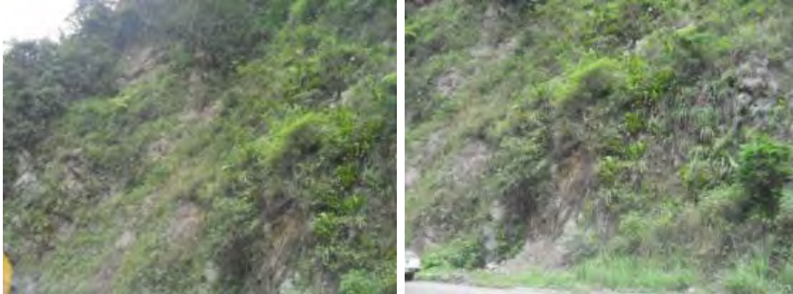
Figura 3 - 25. Salida Túnel 2 - Vista Occidente Oriente –Vista Oriente Occidente - Modificación del Diseño Geométrico del Túnel 2 - K53+260 – K53+560 - Margen Derecho...
