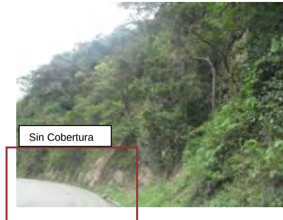
Figura 3 - 36. Sin Cobertura - Realineamiento Túnel 5 - K53+080 – K53+840 Margen Izquierdo.
