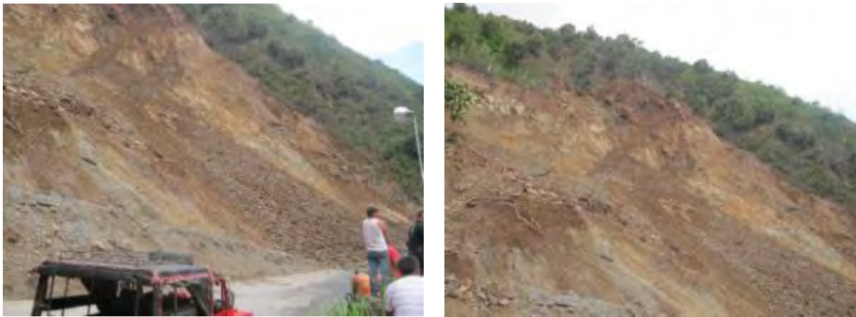
Figura 3 - 53. Sin Uso - Modificación del Diseño Túnel 10 y Construcción de dos (2) Galerías de Evacuación - Margen Izquierdo.
