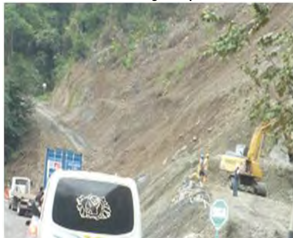
Figura 3 - 73. Acceso adyacente entrada Túnel 10 Margen izquierdo.
