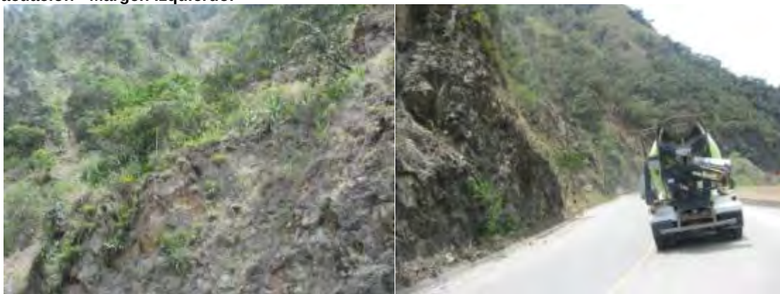
Figura 3 - 58. Arbustal Abierto - Modificación Diseño Túnel 10 y Construcción de (2) Galerías de Evacuación - Margen Izquierdo.
