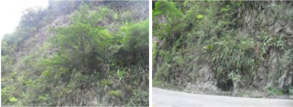
Figura 3 - 24. Entrada Túnel 2 - Vista Occidente Oriente – Vista Oriente Occidente - Modificación del Diseño Geométrico del Túnel 2 - K53+260 – K53+560 - Margen Derecho.
