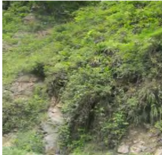
Figura 3 - 9. Uso Actual - Conservación - Modificación del Diseño Geométrico del Túnel 2 - K53+260 – K53+560 - Margen Derecho.
