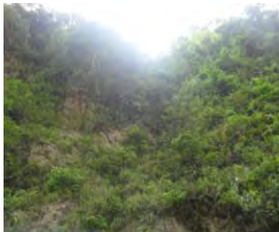
Figura 3 - 10. Tierras con Uso Adecuado – Modificación del Diseño Geométrico del Túnel 2 - K53+260 – K53+560 - Margen Derecho.
