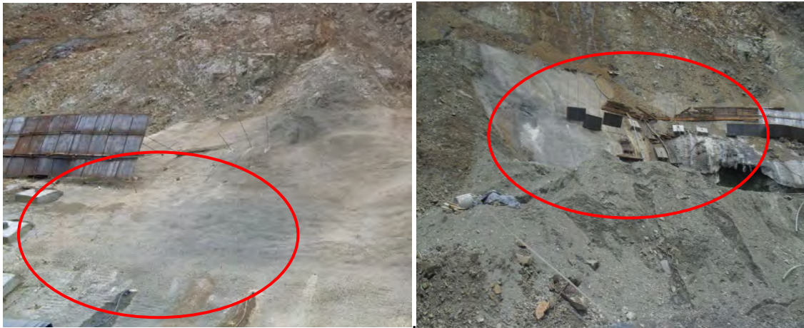
Figura 3 - 55. Labores de Estabilización de los Taludes Portal de Entrada Túnel 10, Ejecutadas por El Consorcio ECC/ Esquema del Tunel Falso entre las abscisas K57+470 – K57+480.
