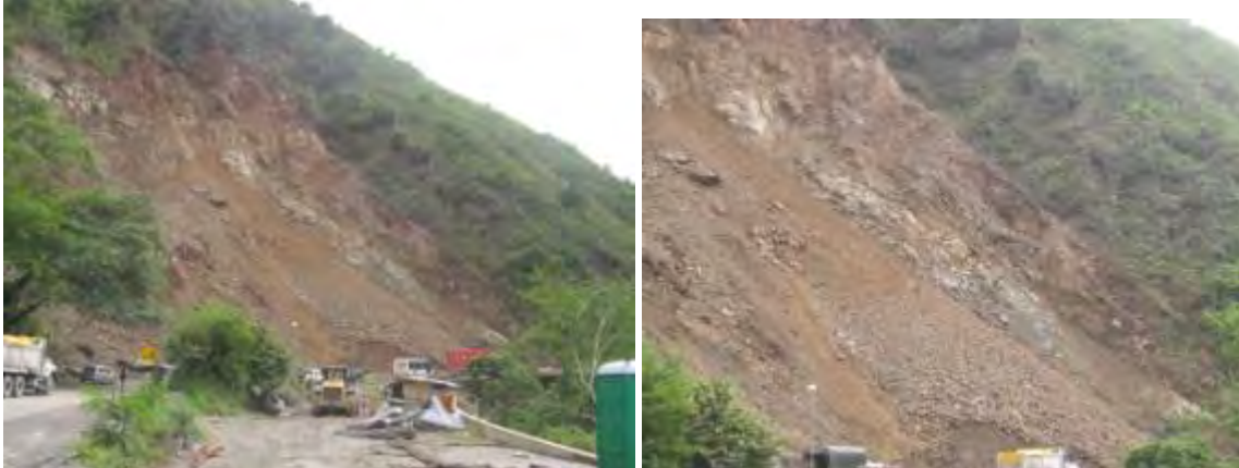
Figura 3 - 60. Sin Cobertura - Modificación Diseño Túnel 10 y Construcción de (2) Galerías de Evacuación - Margen Izquierdo.
