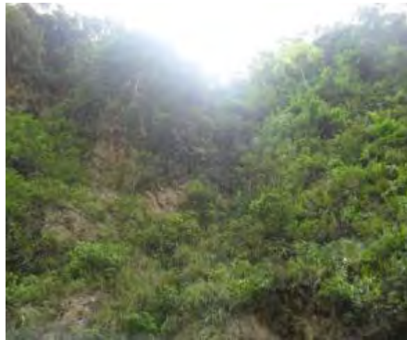
Figura 3 - 56. Tierras con Uso Adecuado – Modificación Diseño Túnel 10 y Construcción de (2) Galerías de Evacuación - Margen Izquierdo.
