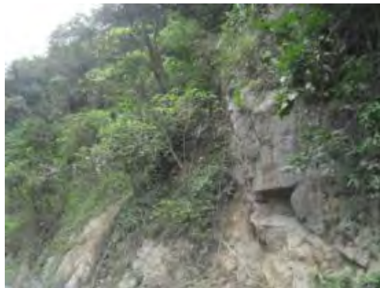
Figura 3 - 46. Salida Túnel 5 Vista Oriente – Occidente - Realineamiento Túnel 5 - K53+080 – K53+840 Margen Izquierdo.
