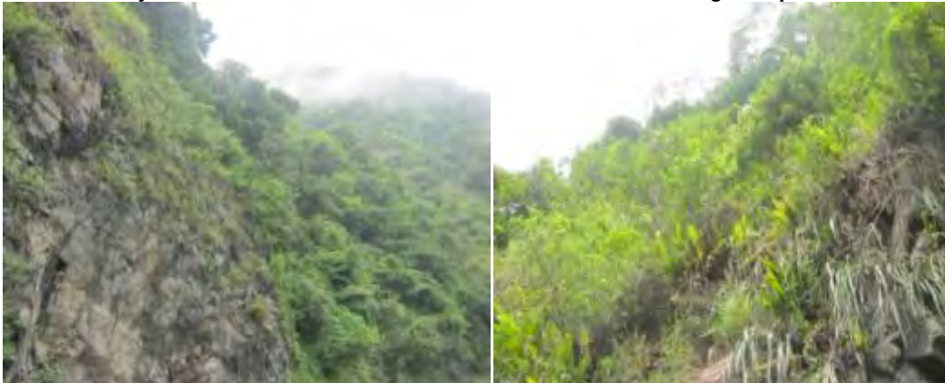
Figura 3 - 33. Paisaje – Realineamiento Túnel 5 K53+080 – K53+840 - Margen Izquierdo.
