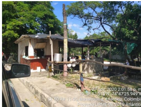
Fotografía 5.17 Infraestructura identificada en el predio 2
