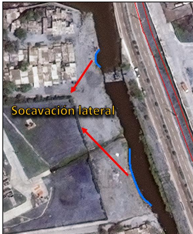
Figura 5.31. Zonas de socavación de orillas
