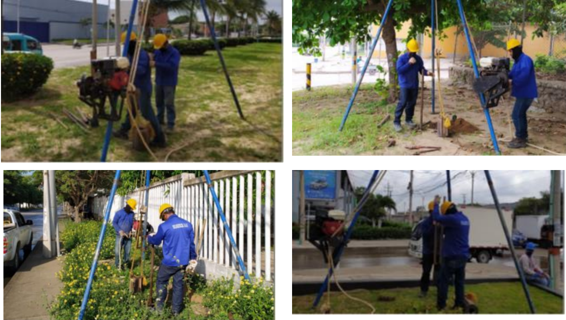
Fotografía 5.22 Sondeos mecánicos ejecutados en la línea subterránea S.E. Termoflores – S.E. Oasis
