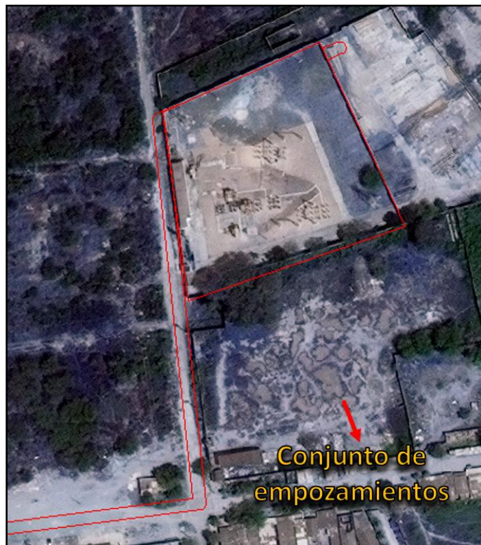
Figura 5.29 Zonas de empozamientos sur de la subestación El Río
