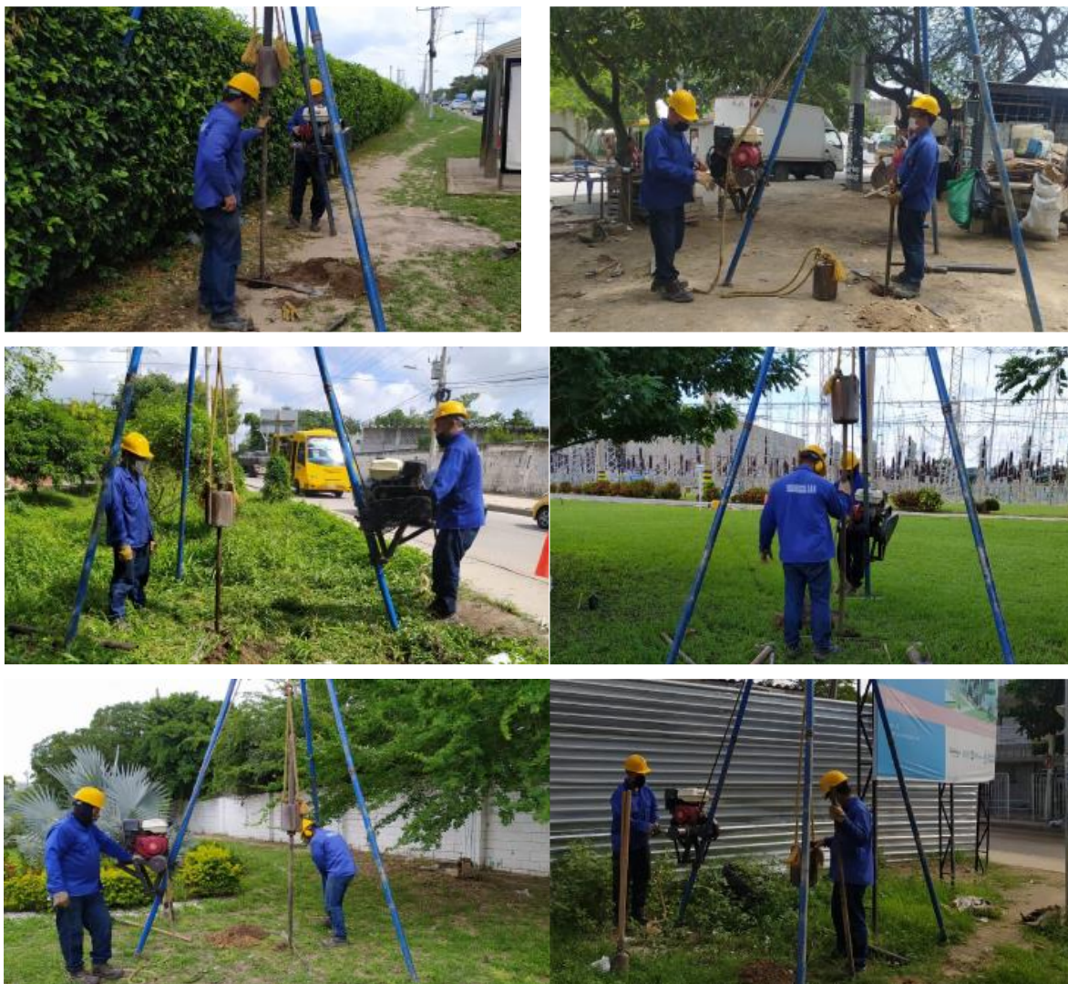
Fotografía 5.26 Sondeos mecánicos ejecutados en la Línea Subterránea a 110 kV S.E. Magdalena – S.E. Tebsa
