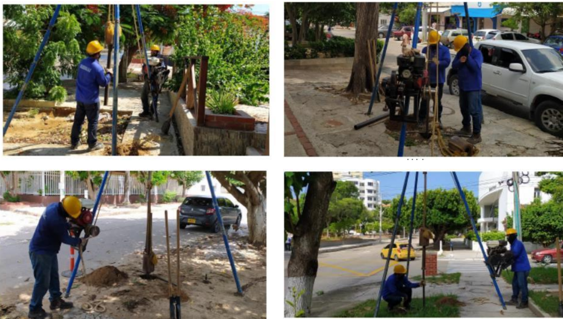
Fotografía 5.23. Sondeos mecánicos ejecutados en la línea subterránea S.E. Oasis – S.E. Estadio
