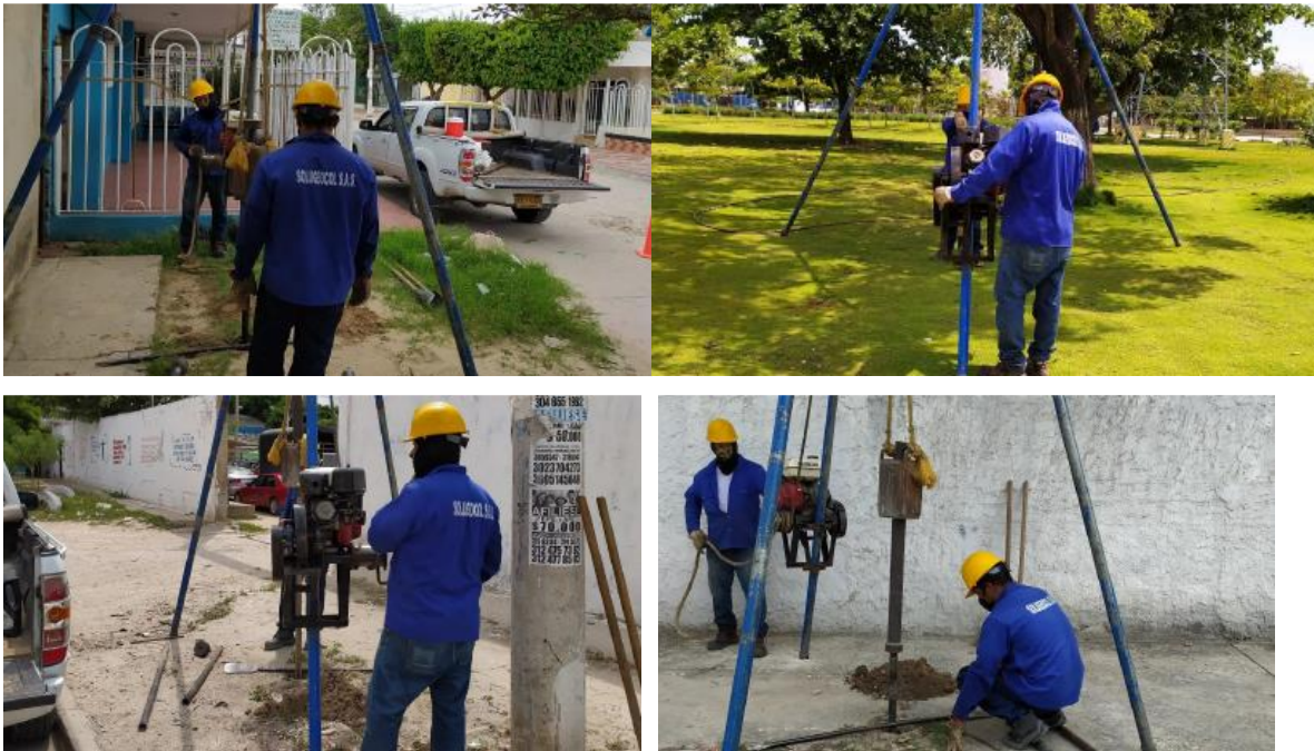
Fotografía 5.27 Sondeos mecánicos ejecutados en la Línea Subterránea a 110 kV S.E. Magdalena – S.E. Unión
