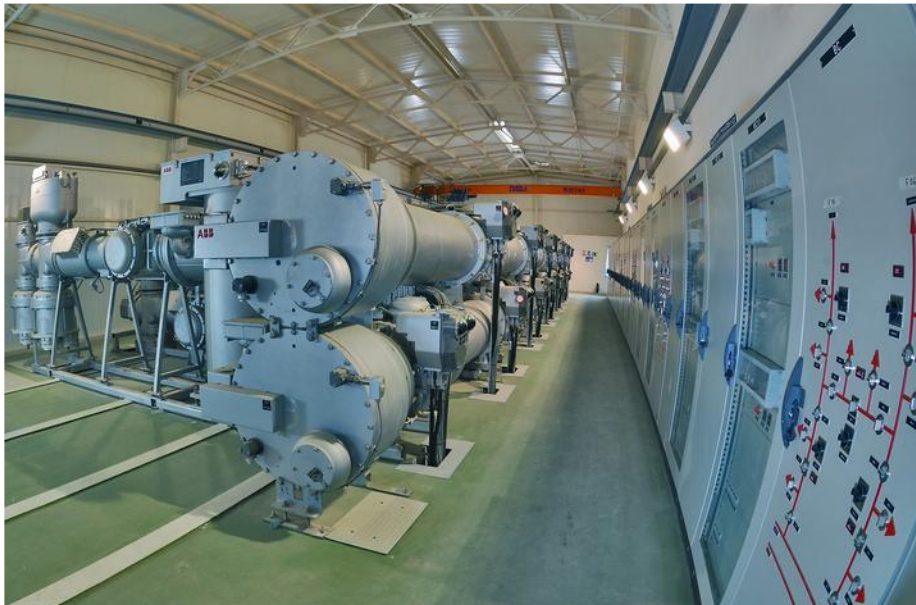
Figura 3.9 Subestación GIS
