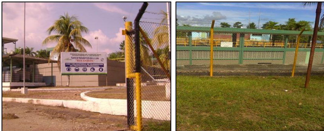
Fotografía 3-35 Planta de tratamiento de aguas Campo 23
