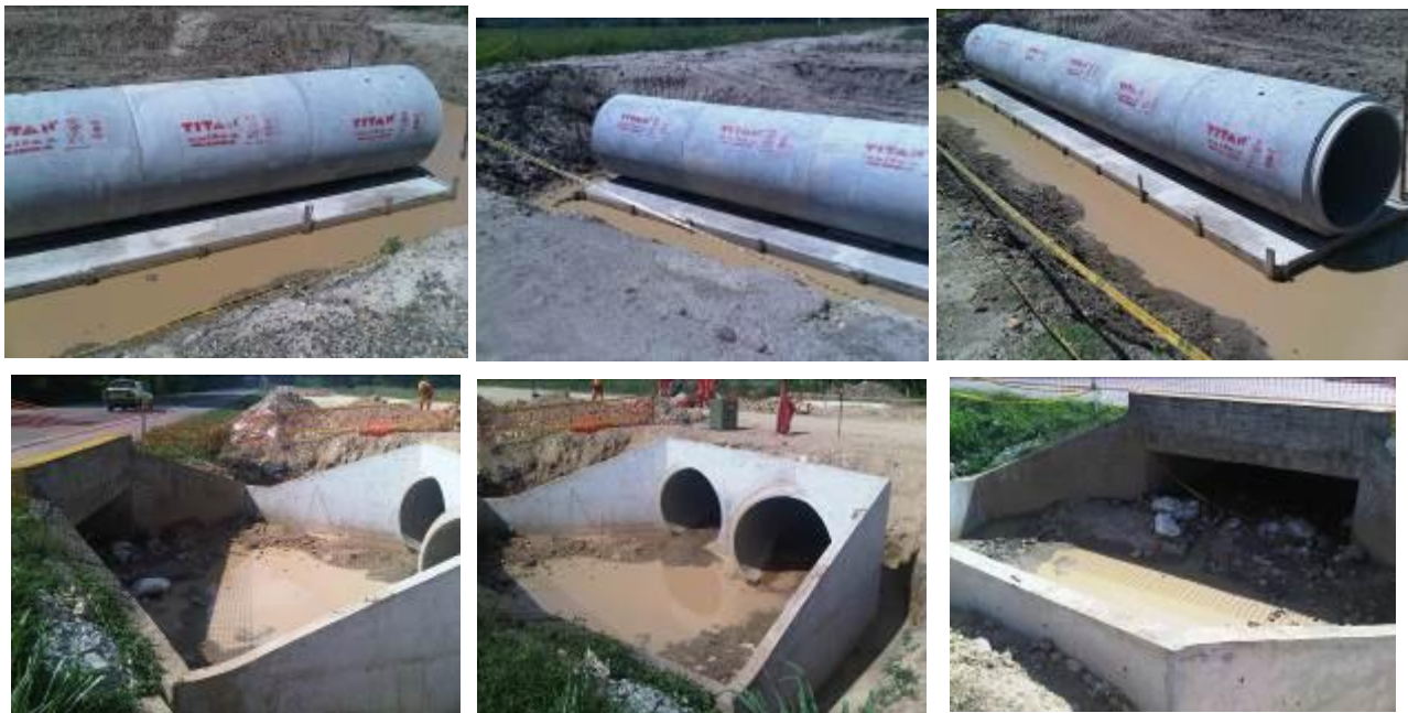
Fotografía 4-3 Proceso constructivo obras menores
