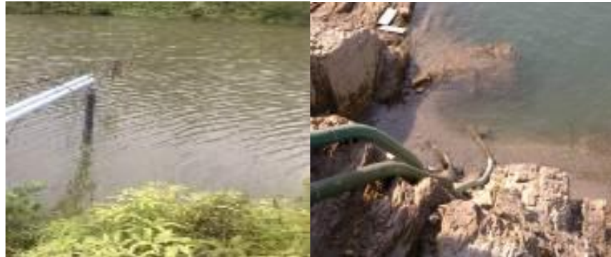
Fotografía 4-2 Sistema de captación de aguas.
