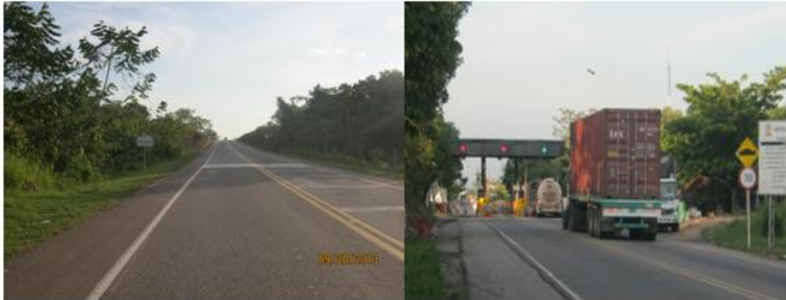
Fotografía 3-16 Red vial Ruta del Sol Tramo 3 sector 2 (Izquierda), Peaje de Aguas Negras (derecha)
