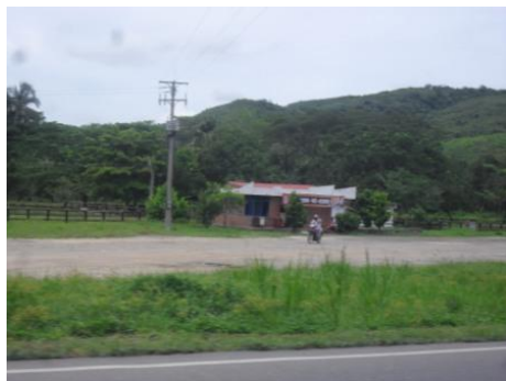
Fotografía 3.4.52 Pozo Redes de Energía de baja tensión
