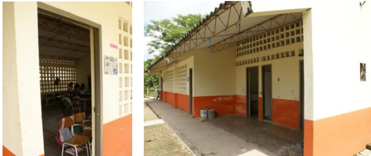
Fotografía 3.4.53 Escuela vereda Trapiche
