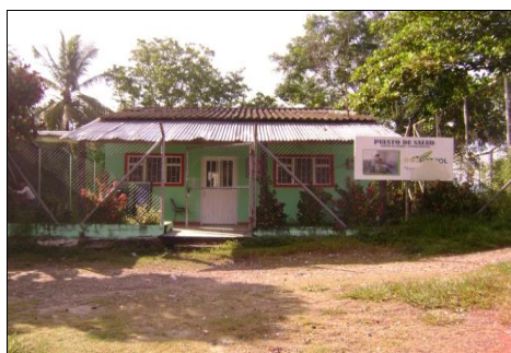
Fotografía 3.4.10 Puesto de Salud del Trique
