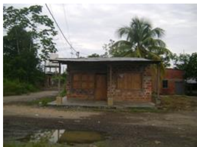
Fotografía 3.4.17 Tanque elevado Palmas del Guayabito
