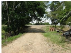
Acceso Vereda Matarredonda PR 12+400 (I)
