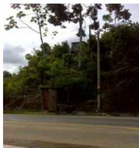
Fotografía 3.4.18 Pozo y Tanque elevado Vereda El Cucharo
