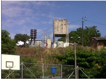
Fotografía 3.4.5 Acueducto veredal El Trique
