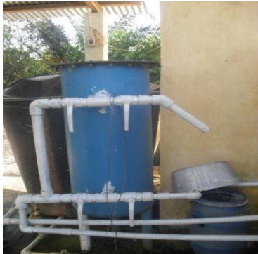
Fotografía 3.4.37 Extracción con bombas a través de filtros
