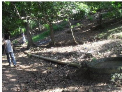
Fotografía 3.4.51 Pozo Séptico de la finca los Serenos
