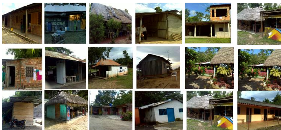
Fotografía 3.4.112 Tipo de viviendas tramo 3
