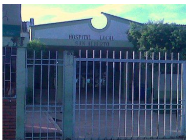
Fotografía 3.4.40 Hospital Local de San Alberto
