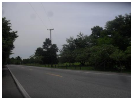
Fotografía 3.4.39 Redes de Energía ubicadas en el tramo 4
