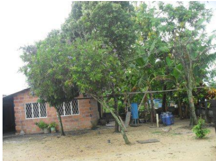
Fotografía 3.4.45 Vivienda Vereda La Retirada
