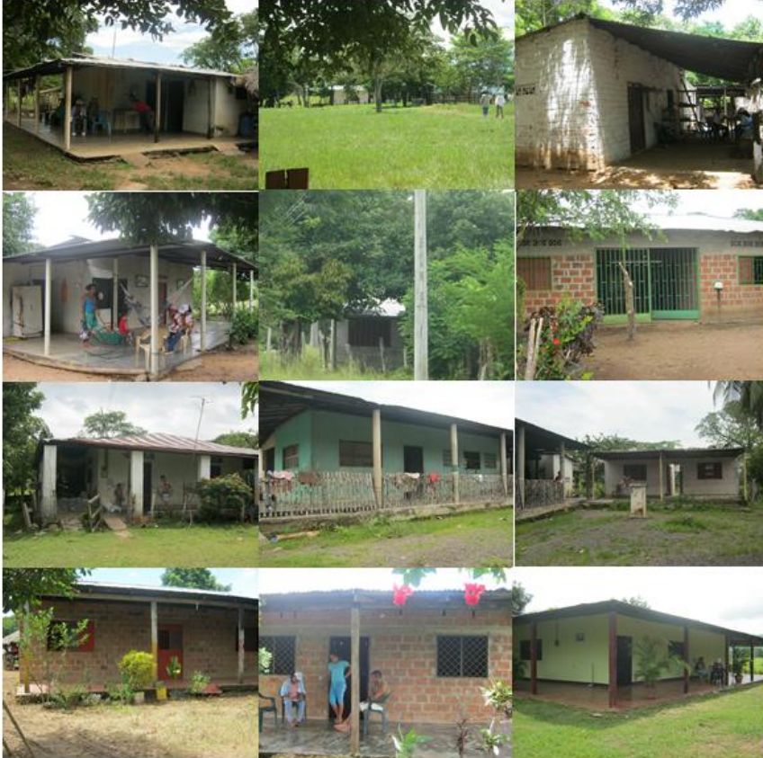
Fotografía 3.4.119 Viviendas ubicadas en el municipio de Pelaya
