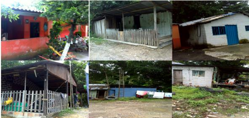
Fotografía 3.4.116 Viviendas que se encuentra la zona de requerimiento predial en el sector de las Mirlas
