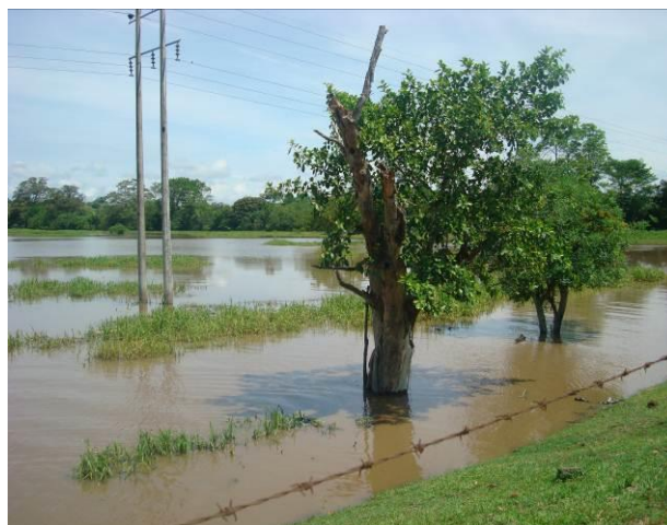
Tramo 2 – Ruta 4510 – PR 94 a PR 94+500 Zonas bajas inundadas sector dos y medio
