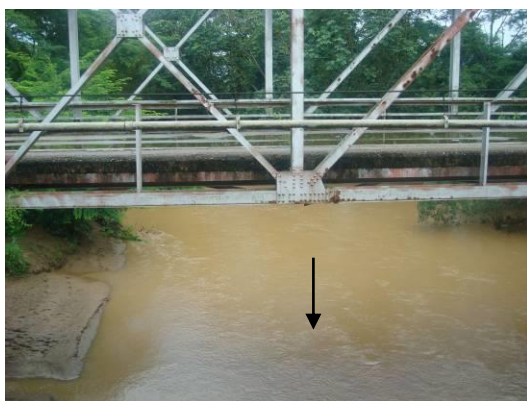
Vista hacia aguas arriba – Puente abandonado
