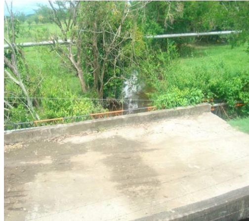
Tramo 2 - Ruta 4510 PR 99+0900 Al fondo Tubería de 12" de ECOPEPETROL, Tubería de 6" de TELECOM y Puente Abandonado
