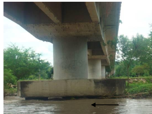
Infraestructura del puente
