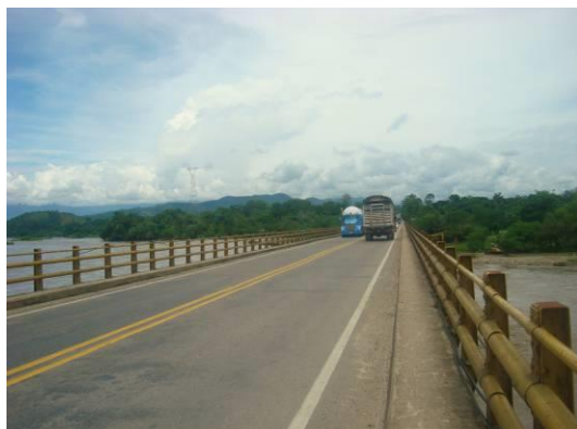
Superestructura del puente de luz de 700 m.
