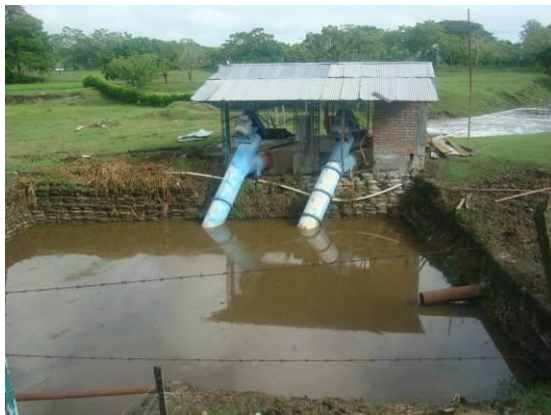
Tramo 2 - Ruta 4510 PR 130+0100 Sistema de bombeo aguas abajo de la vía. Fotografía 3-38 Cruces con redes (a)
