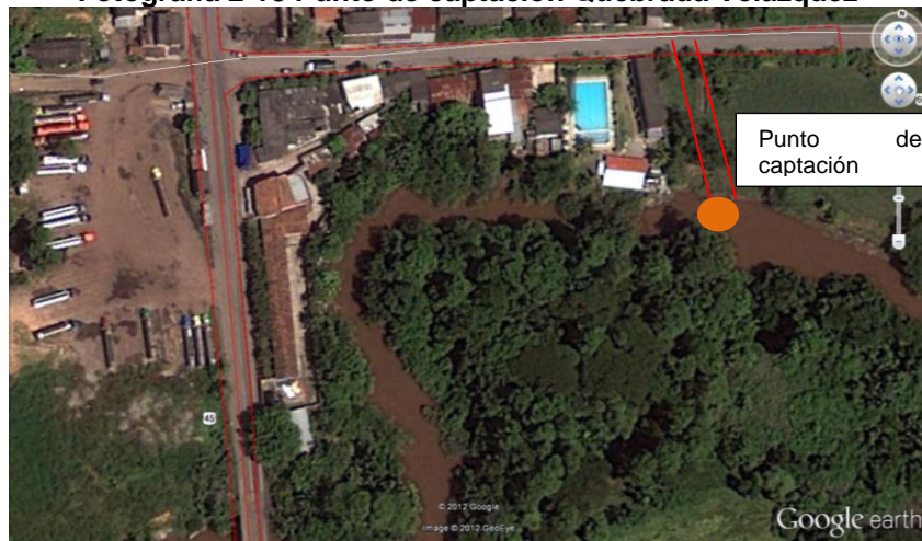
Fotografía 2-18 Punto de captación Quebrada Velázquez
