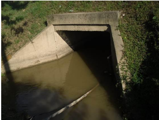
Fotografía 2-3 Cruce de red de acueducto
