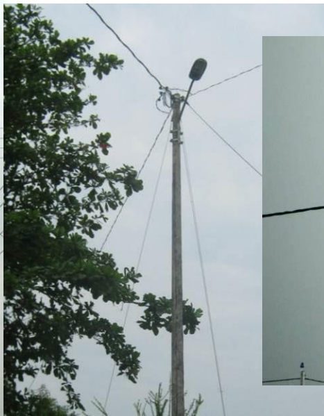
Fotografía 2-16 Red secundaria trenzada
