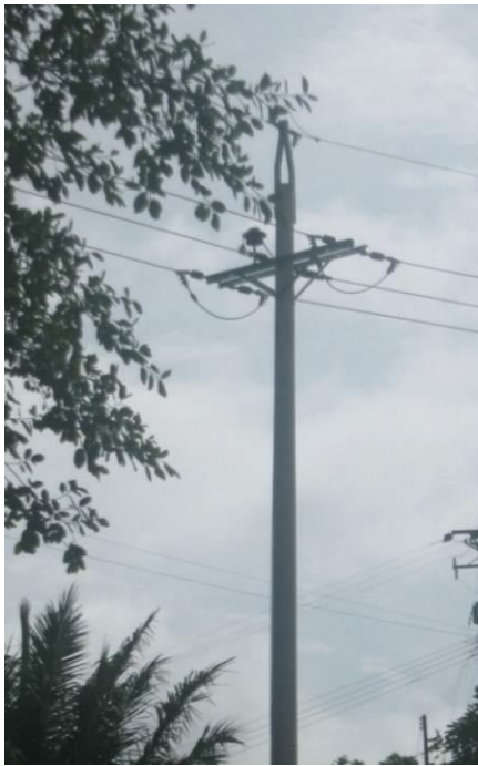
Fotografía 2-9 Red primaria a 13,2 kV, cuatro hilos, retención
