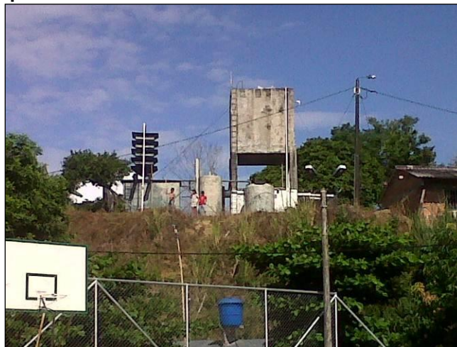
Fotografía 3-16 Tanque elevado del acueducto veredal ubicado en el asentamiento veredal
