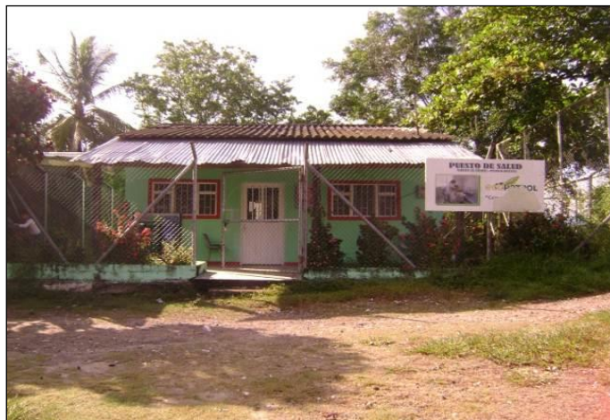
Fotografía 3-24 Puesto de Salud ubicado sobre el costado derecho de la vía actual
