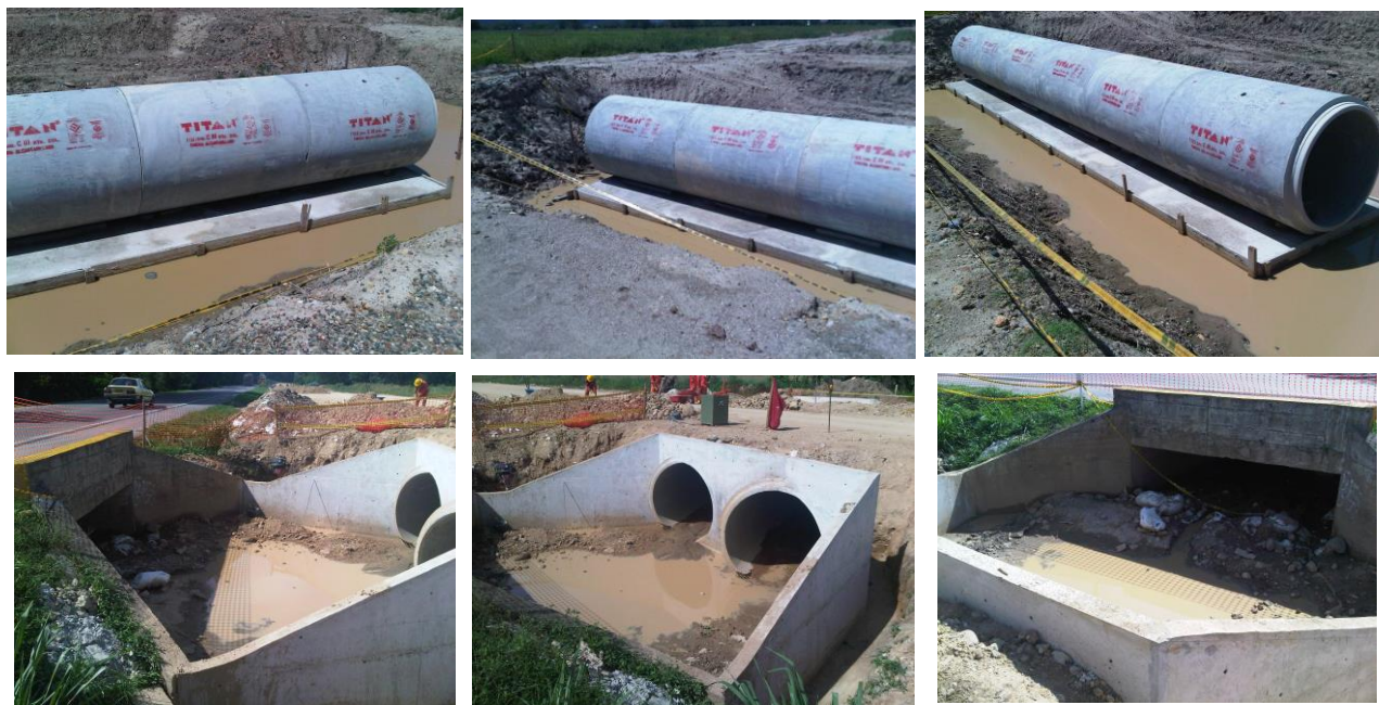
Fotografía 4-2 Proceso constructivo obras menores
