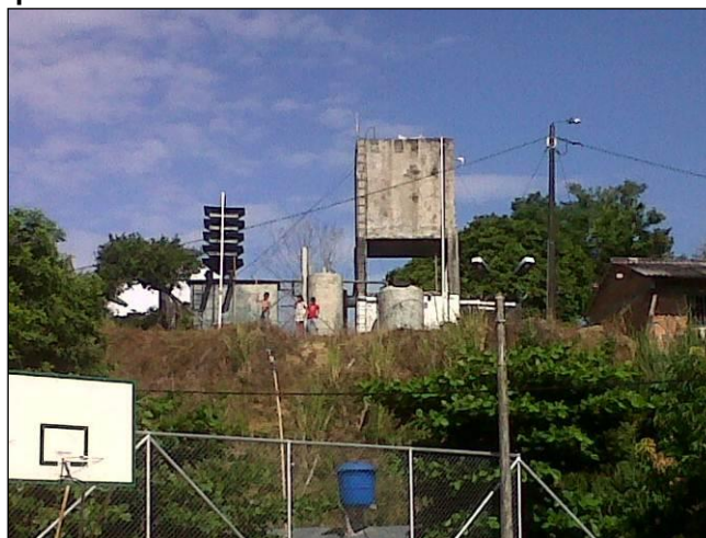
Fotografía 3-16 Tanque elevado del acueducto veredal ubicado en el asentamiento veredal
