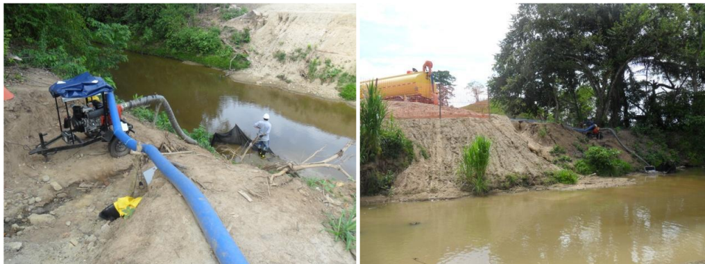
Fotografía 4-1 Sistema de captacion de aguas
