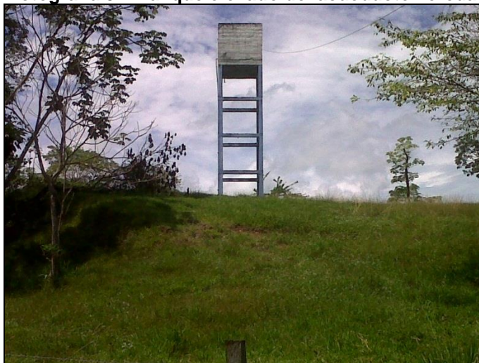
Fotografía 3-1 Tanque elevado del acueducto veredal
