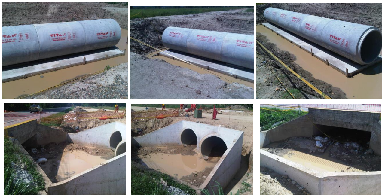
fotografía 4-2 Proceso constructivo obras menores
