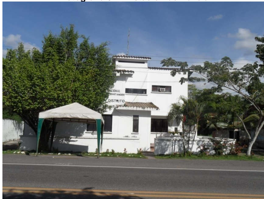
Fotografía 3-72 Estación de Policía
