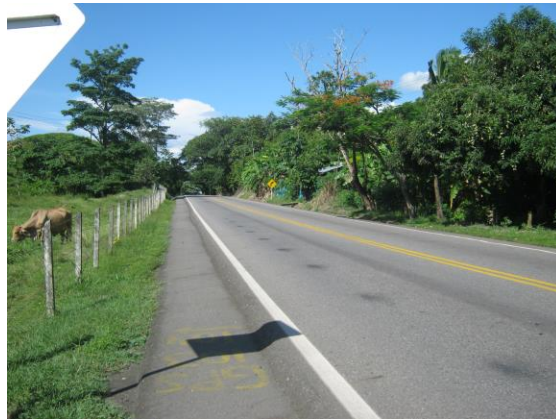
Fotografía 3-14 via nacional que conduce al corregimiento de puerto araujo y fin de la variante Km 28.
