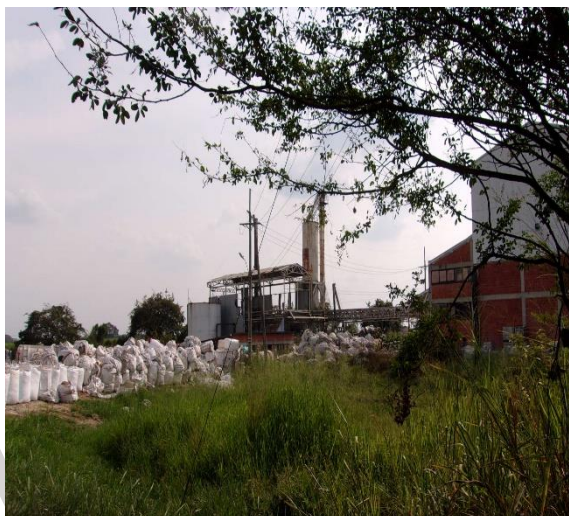
Fotografía 5.2-13. Planta transformadora de cartón
