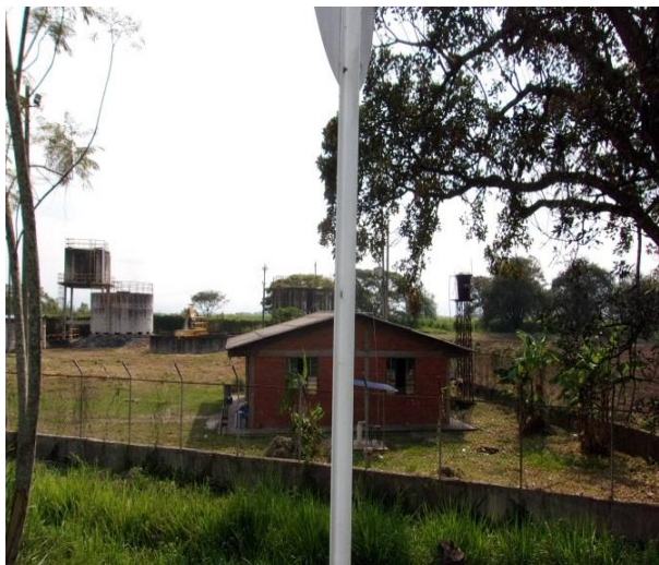
Fotografía 5.2-12. PTAR de Villa Rica
