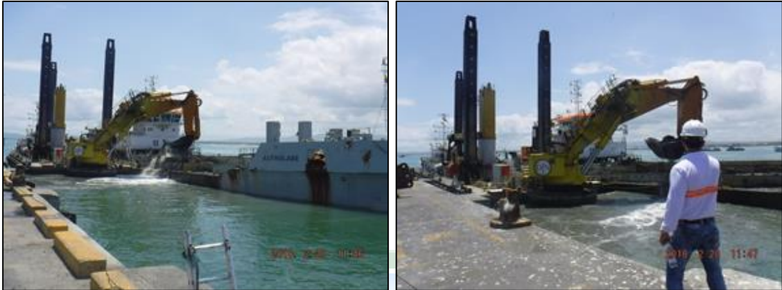
Figura 11. Dragado y descarga en barcaza SHB
