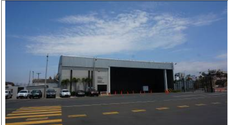
FOTO No. 6. EDIFICIO POLICÍA ANTINARCÓTICOS
