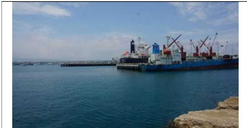
FOTO No. 1. ADELANTE MUELLE INTERNACIONAL 1, ATRÁS MUELLE INTERNACIONAL 2 EXTENDIDO 100 M
