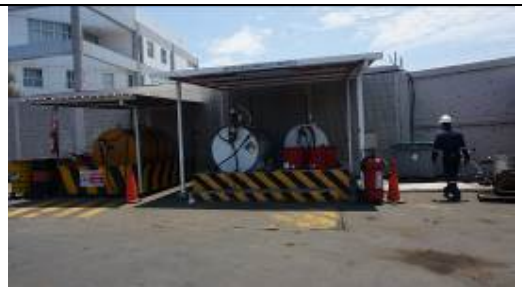
FOTO No. 8. ÁREA COMBUSTIBLES
