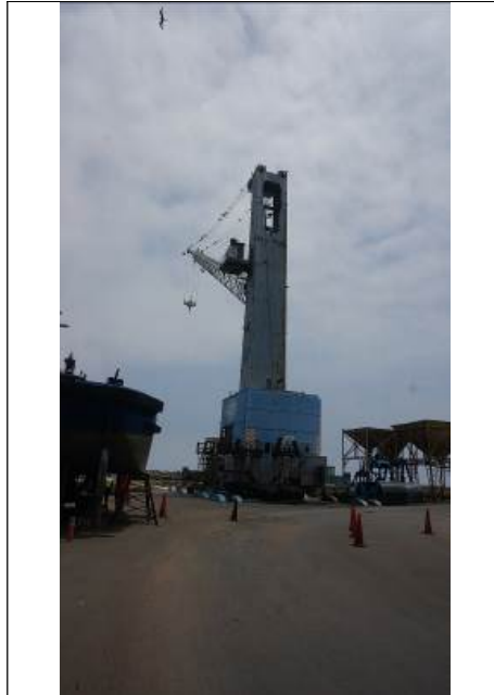
FOTO No. 9. GRÚA MÓVIL SIN USO
