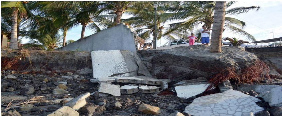
Figura 4-28. JAMA, Manabí. Una pared cayó en el sector por el fuerte oleaje.
