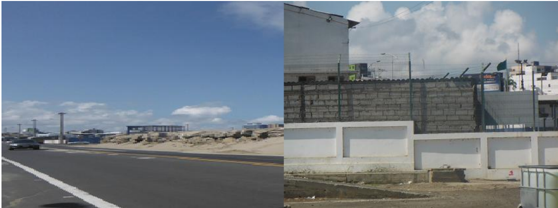
Fotografía 3-1. Vista del Patio 500.
