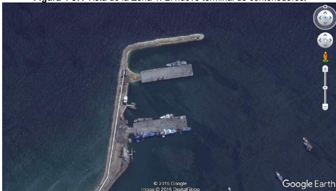
Figura 4-97. Vista de la Zona 1. El nuevo terminal de contenedores.
