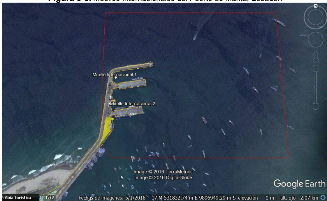
Figura 3-3. Muelles Internacionales del Puerto de Manta, Ecuador.
