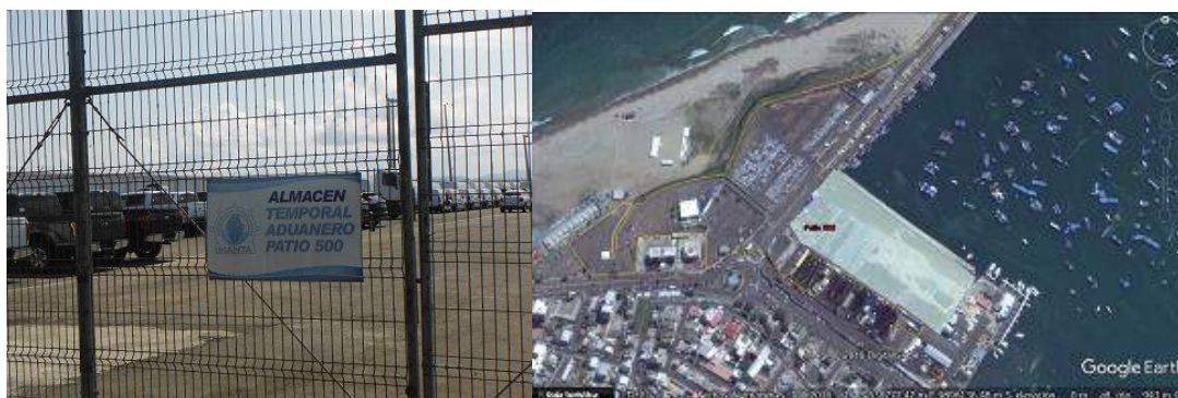
Fotografía 3-2. Patio 500. Cerramiento y pavimento
