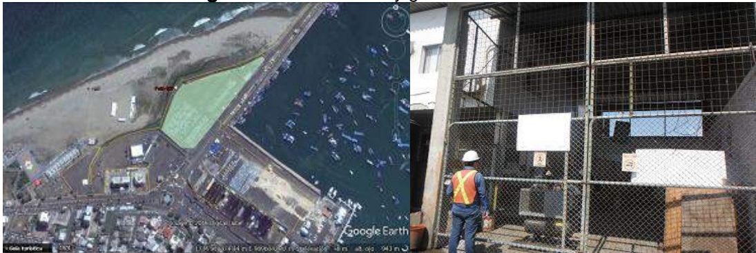
Fotografía 3-3. Patio 600 y generador de corriente.
