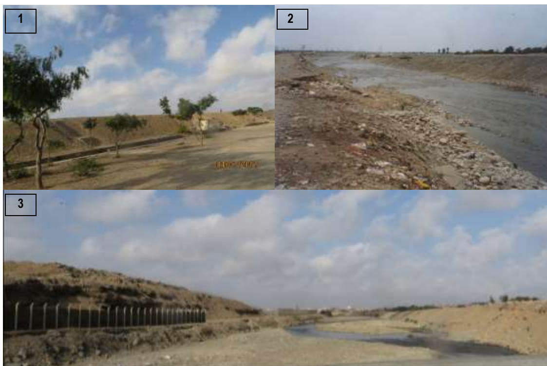
Fotos 1,2 y 3. Defensas ribereñas (1) , construidas a lo largo del cauce del río Rímac, protege las vías (Av. Morales Duárez) y viviendas contiguas; Cauce actual (2) y (3) Vista longitudinal , desde el puente en el cruce de las Av. Néstor Gambetta y Morales Duárez. se puede observar el lecho fluvial, y la unidad contigua, cuyo desnivel no supera los 4 m.
