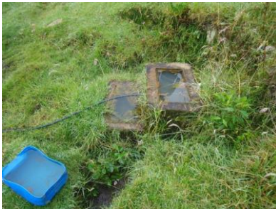
Fotografía 2.9 Tanque de recolección en un nacedero de la Vereda Tablón Alto. Coordenadas (Magna Sirgas Origen Oeste) E: 954060 N: 604342
