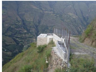
Fotografía 2.10 Acueducto del condominio Arcoiris (Pilcuan). Coordenadas (Magna Sirgas Origen Oeste) E: 954060 N: 604342
