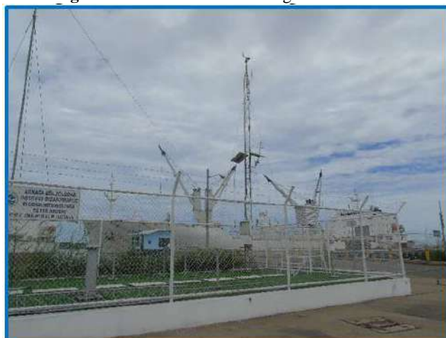
Fotografía 5: Estación Meteorológica Puerto Bolívar
