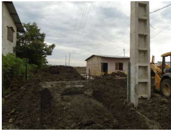
MATERIAL DE RELLENO A ASENTAMIENTO VIRGEN DEL CISNE
