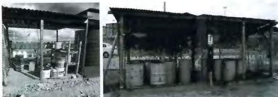
Imágenes ilustrativas de un recinto de sustancias químicas y/o peligrosas en el Obrador central
