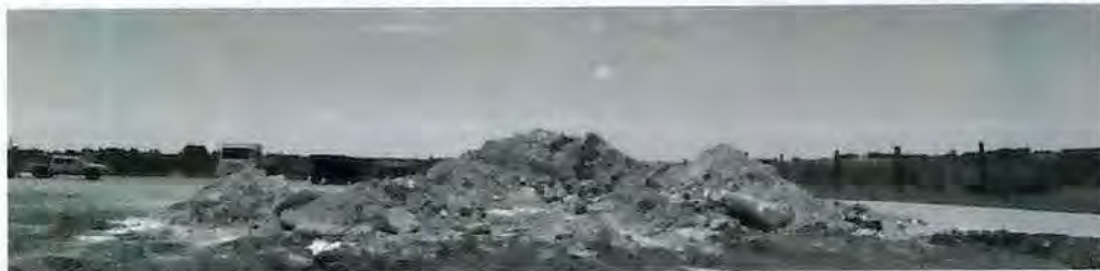
Imágenes ilustrativas de puntos limpios (Acopio transitorio de escombros)
