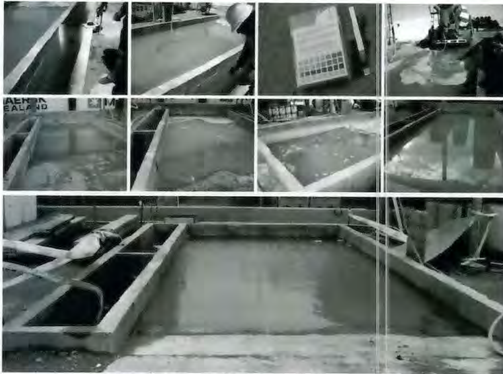
Imagen ilustrativa de pileta de lavado de Mixer y su control
