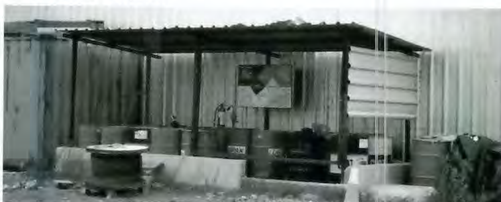
Imagen ilustrativa de un recinto de combustibles, lubricantes y/o líquidos hidráulicos
