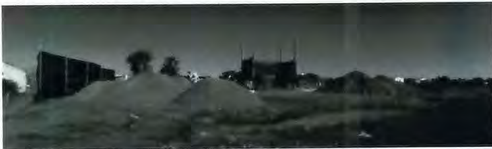
Imagen ilustrativa de acopio de áridos
