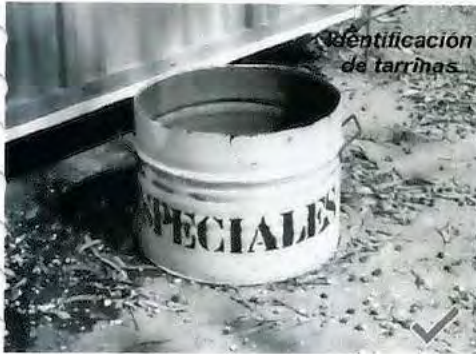
Incorrecto acopio Ausencia de tapas y bandejas
