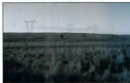
Plano ondulado fuerte (subestación Melo)
