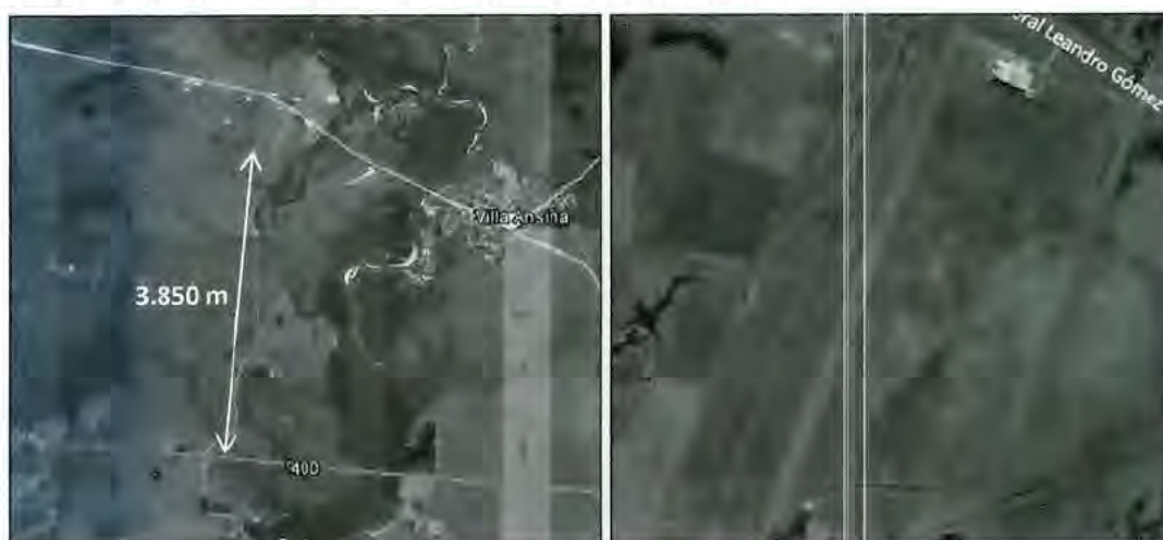
Figura 4-25: Aeródromo Joaquín "Ansina" Lenzina. Izquierda: Imagen satelital del aeródromo con referencia a la LAT (línea fucsia). La flecha doble indica la distancia mínima entre la pista y la LAT Derecha: Imagen satelital del predio del aeródromo.
