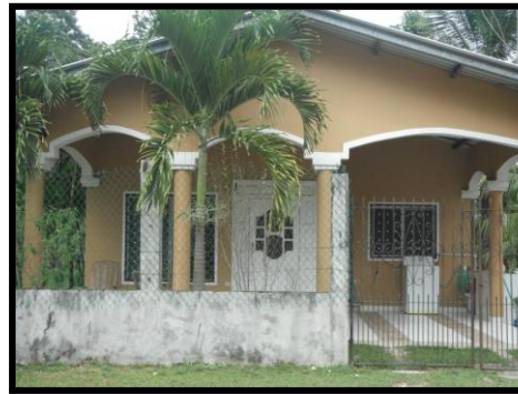
Casa para personal técnico y administrativo
