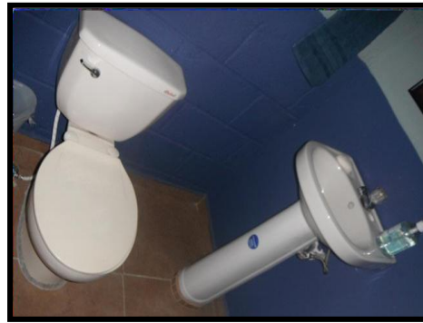
Sanitario del campamento
