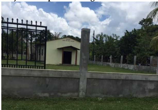
Foto 5 Mejora de la pared de la iglesia del Caserío El Retiro
