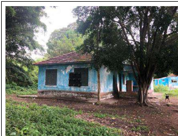
Foto 3.1-3: Casa dentro do terreno (caseiro) (Fonte: Sabesp, 12/2019).
