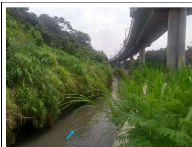
Foto 3.2-2: Vista da área frontal da URQ (à esquerda), com o córrego Morro do S na frente e a linha do metro na parte superior (Fonte: Sabesp, 01/2020).
