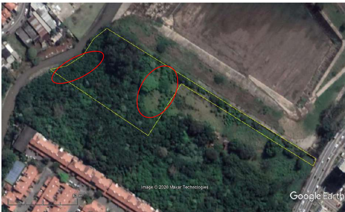
Imagem 4.1.3-7: Imagem Google Earth de 6/09/2019, a mais recente disponível, mostrando a inexistência de qualquer edificação remanescente na área da URQ e a cobertura integral por vegetação nativa. As elipses em vermelho indicam as áreas onde há evidências de aterros com solos/materiais alóctones.
