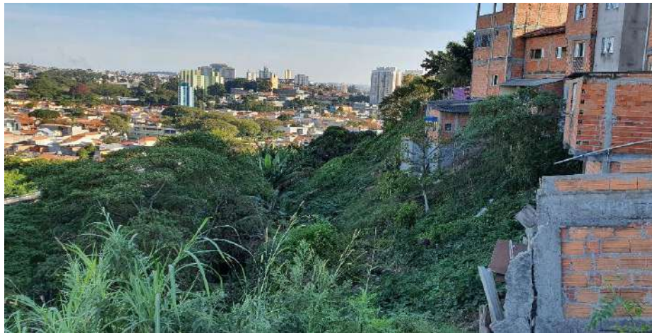
Foto 4.2.2.1-1: Aspecto da encosta na Área da URQ Cachoeira, com altas declividades e suscetível a movimentos de massa (Ecodue, 2020).
