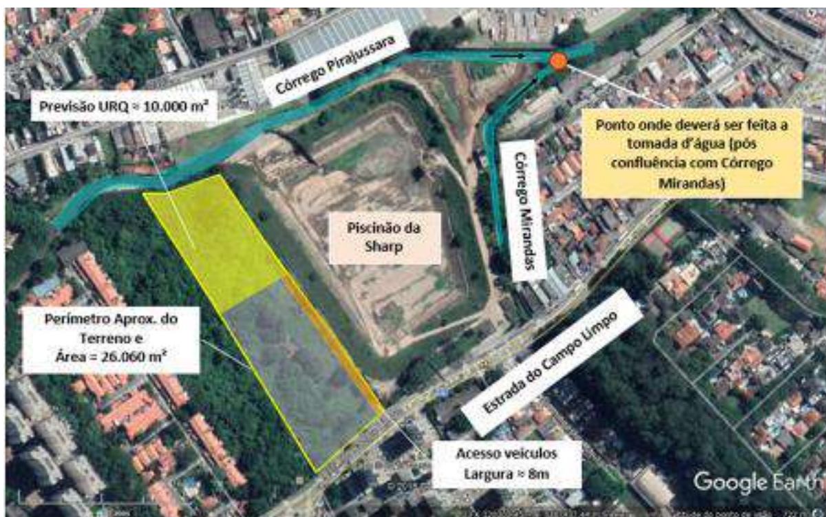
Figura 3.1-1: Localização da URQ Pirajussara, na Estrada do Campo Limpo, nº 5.965 (Fonte: Sabesp, 09/03/2020).
