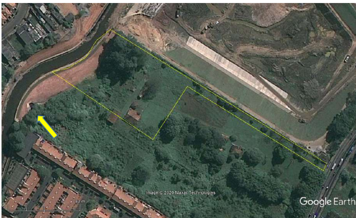
Imagem 4.1.3-4: Imagem Google Earth de 20/05/2009. Aterro da canalização do rio Pirajussara finalizado. Notar à esquerda da foto um bueiro – seta amarela -para a passagem de águas pluviais drenadas da área onde se inere a URQ.
