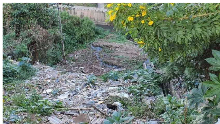
Foto 4.2.3-3: Foto já mostrada anteriormente, de maio de 2020, mostrando o escorregamento sobre o depósito de resíduos alcançando o córrego do Morro do S (Ecodue, 2020).
