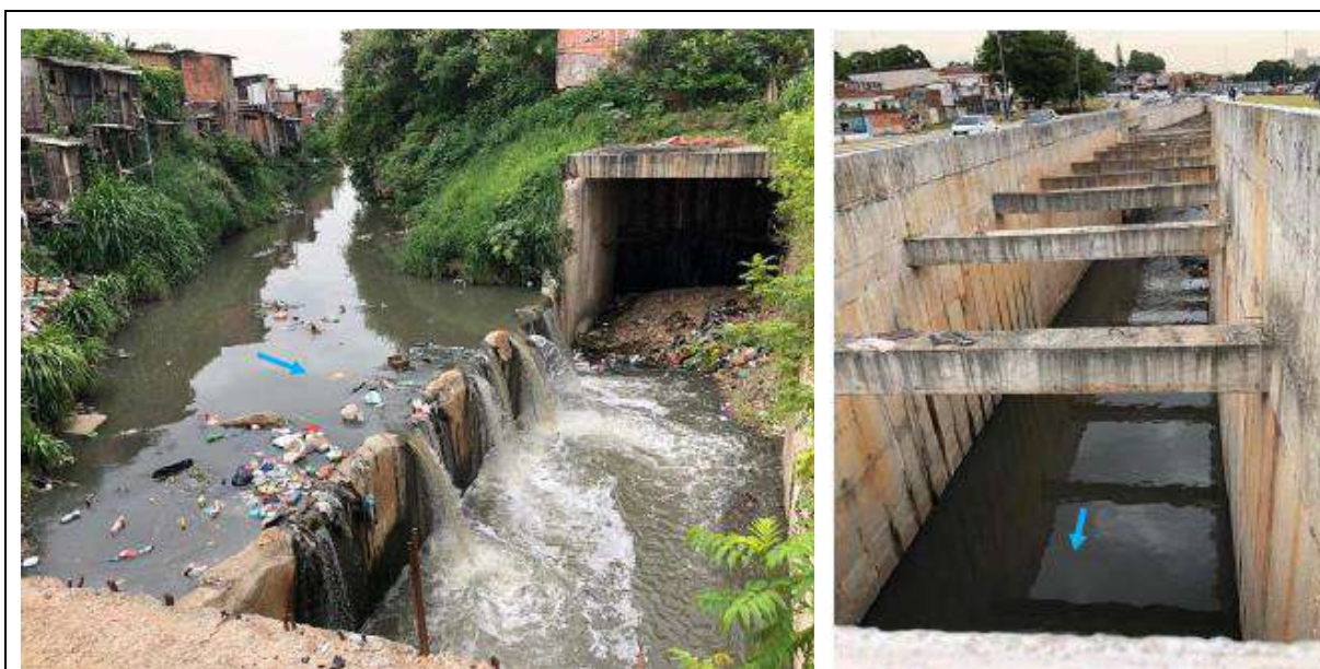
Foto 3.3-4: Córrego Água Espriada (Fonte: Sabesp, 12/2019).
