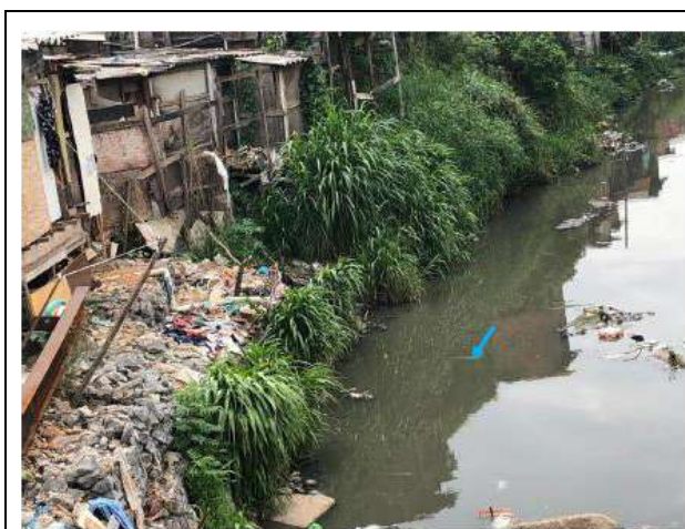
Foto 3.3-3: Córrego Água Espriada (Fonte: Sabesp, 12/2019).
