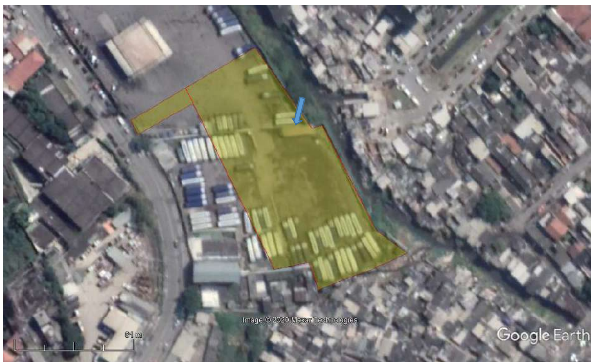
Imagem 4.3.3-3: Imagem Google Earth de 6/092019. Uso por garagem de ônibus mantido. Acrescida apenas uma edificação, apontada pela seta azul.
