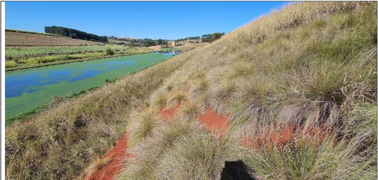
Foto 5: Em primeiro plano o talude de aterro .com exposição parcial do solo por deficiência da cobertura vegetal (capim barba de bode) e a berma de equilíbrio, feição que não está considerada para a implantação dos painéis.
