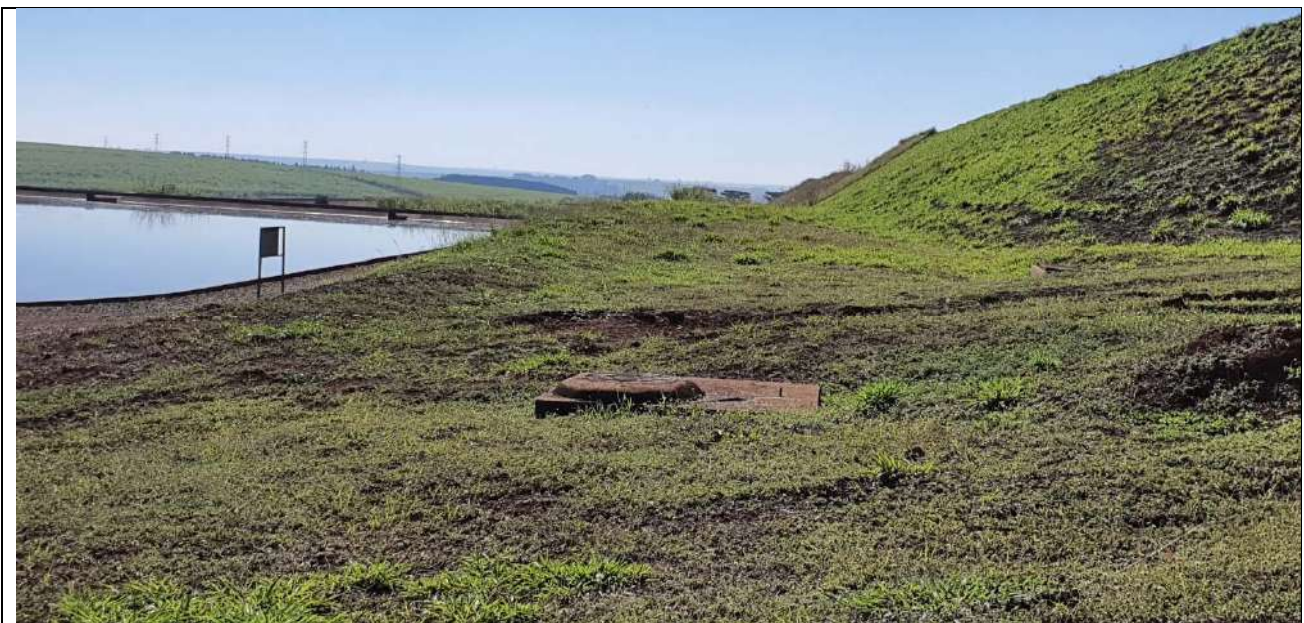
Foto 4: Área destinada à UFV, constituída por faixa de terreno plano sem uso, entre talude de aterro e lagoa
