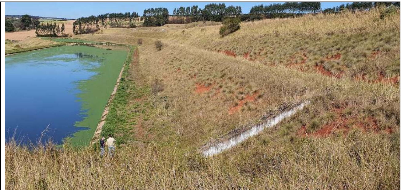
Foto 4: Aspecto de uma das lagoas da ETE e do talude adjacente, em duas bancadas e uma berma de equilíbrio. Em primeiro plano uma descida d'água em escada hidráulica.
