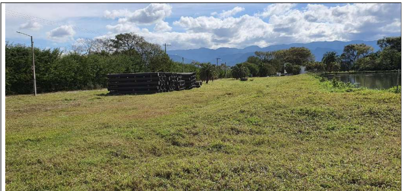
Foto 5: Aspecto área destinada à UFV, lado oeste. Notar estoque de tubos de aço a serem utilizados em obras de saneamento em andamento na região.
