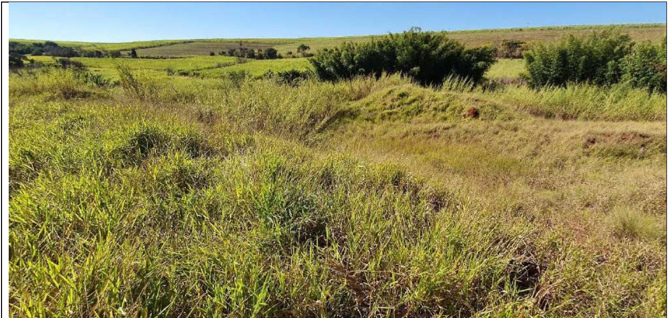
Foto 7: Mesma área da foto anterior, com visada para jusante. Notar pilhas de solo e depressão utilizada para a contenção das águas pluviais lançadas pelo sistema de drenagem pluvial adjacente à ETE. Esta área deverá sofrer regularização topográfica previamente à implantação dos painéis.
