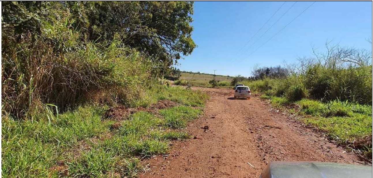
Foto 1: Aspecto de acesso à ETE São Manoel, em estrada de terra com boas condições de trafegabilidade.
