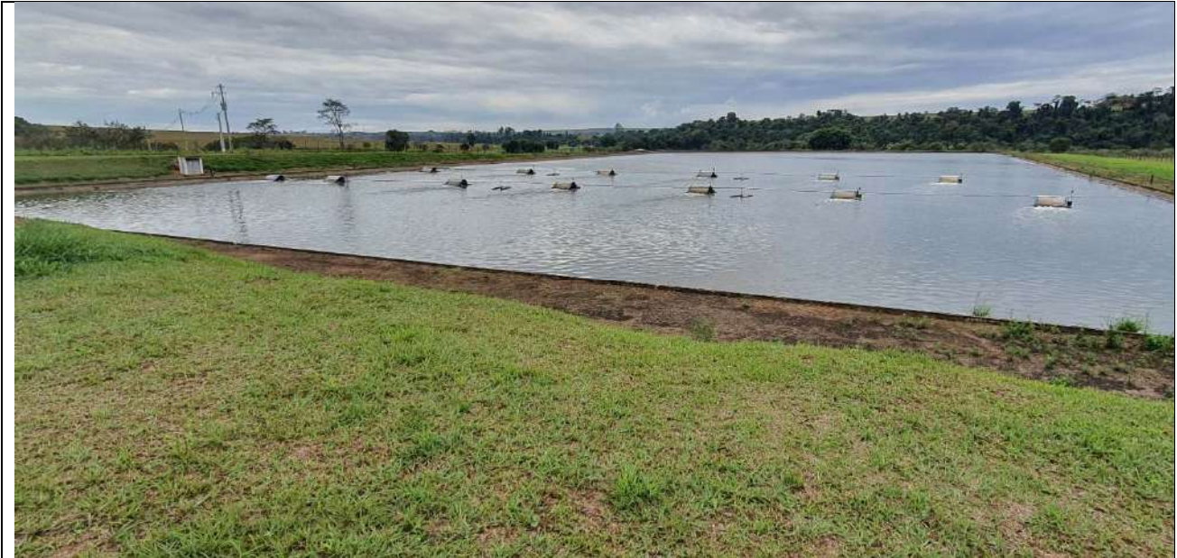
Foto 3: Aspecto geral da ETE.
