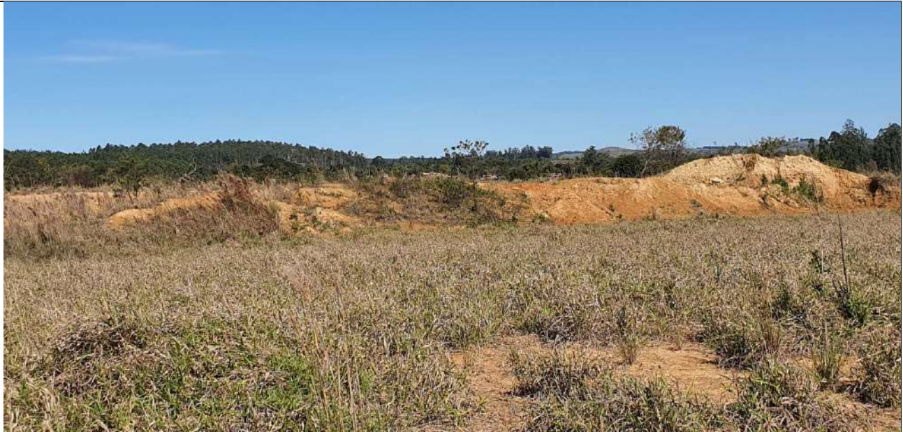
Foto 3: Bota-fora de solos de escavação das obras de implantação da ETE no topo da área destinada à URQ.
