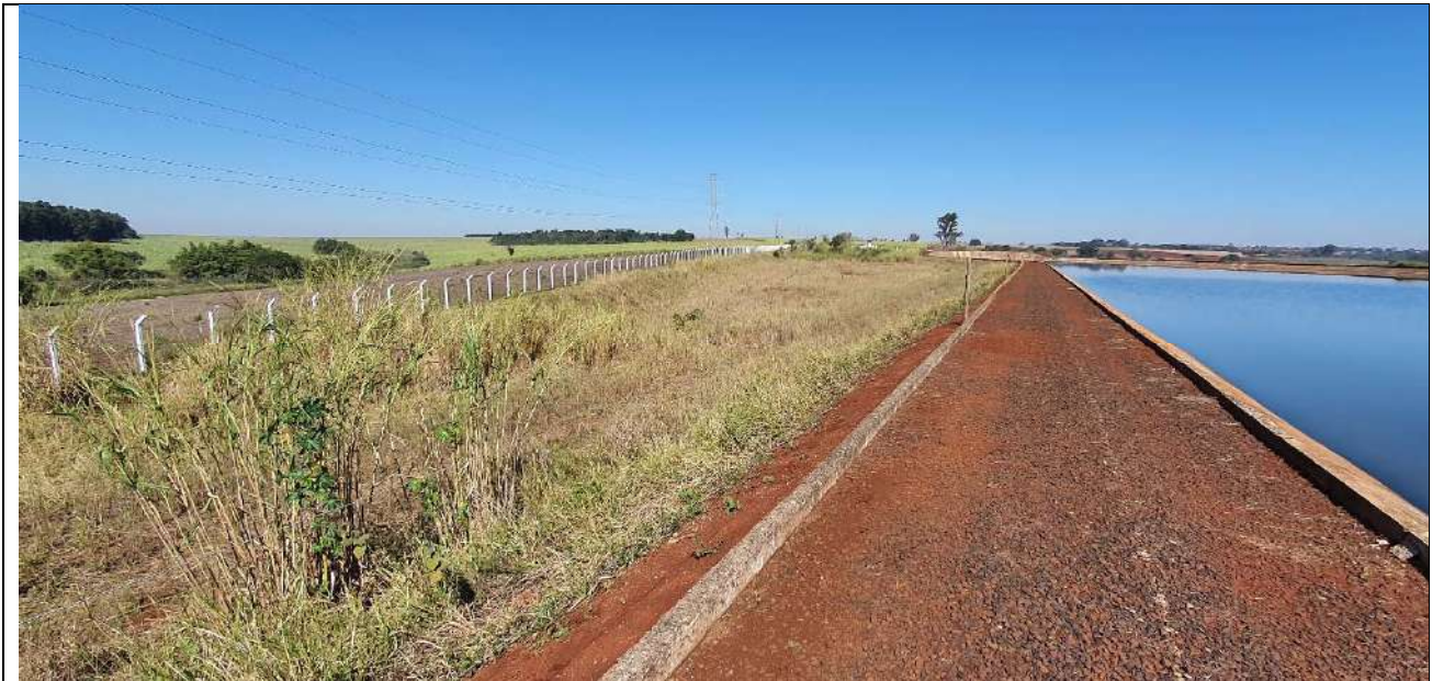
Foto 5: Área para a UFV na porção superior do terreno. Antiga jazida de solo para construção da ETE.
