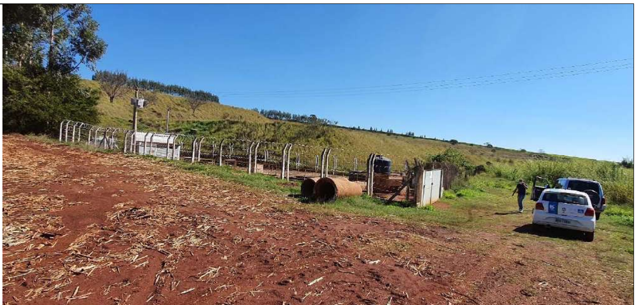
Foto 2: Entrada da ETE. Em primeiro plano a Estação Elevatório final.
