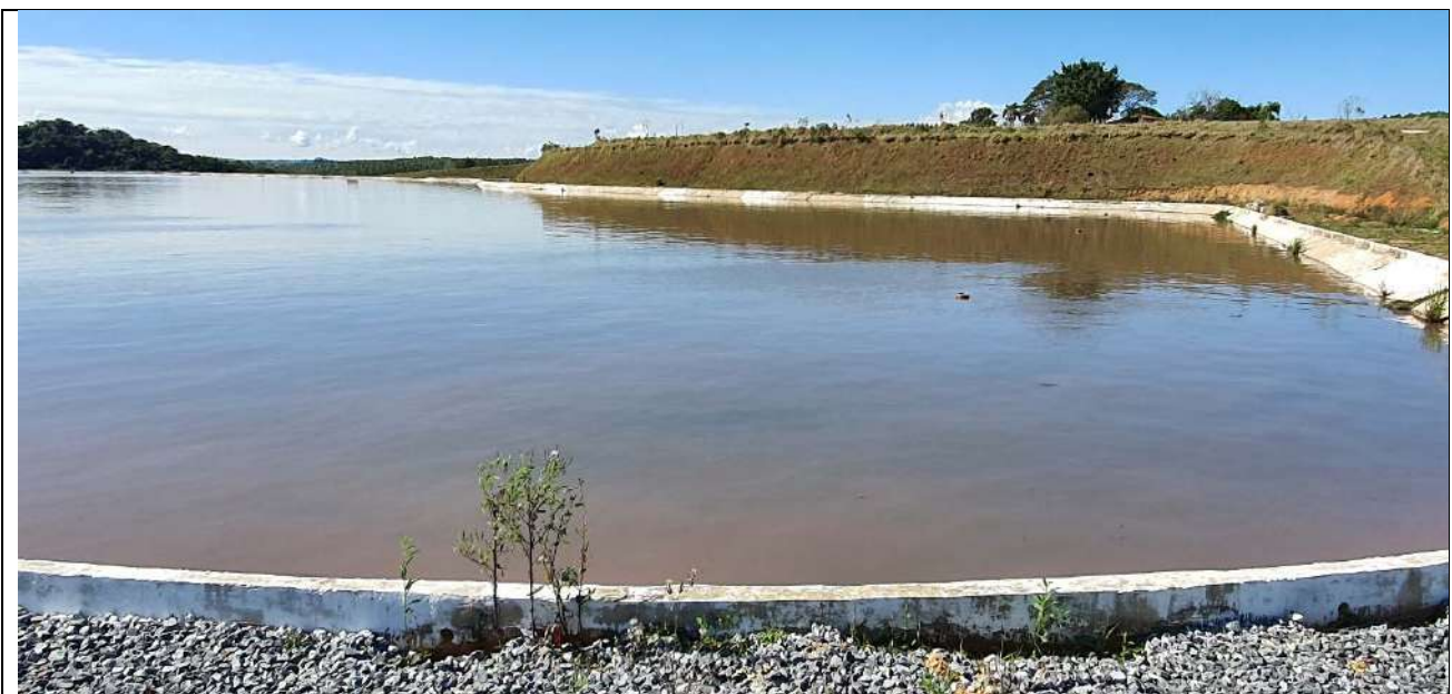
Foto 6: Aspecto de uma das lagoas da ETE. Ao fundo, árvores isoladas junto da edificação da antiga sede da propriedade, a ser demolida.
