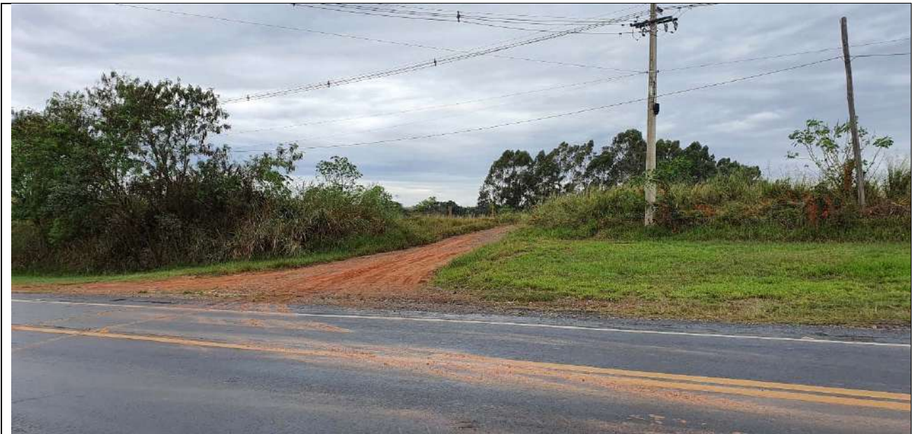
Foto 1: Acesso à ETE a partir da rodovia Antonio Rossi, em estrada de terra em boas condições tráfego.
