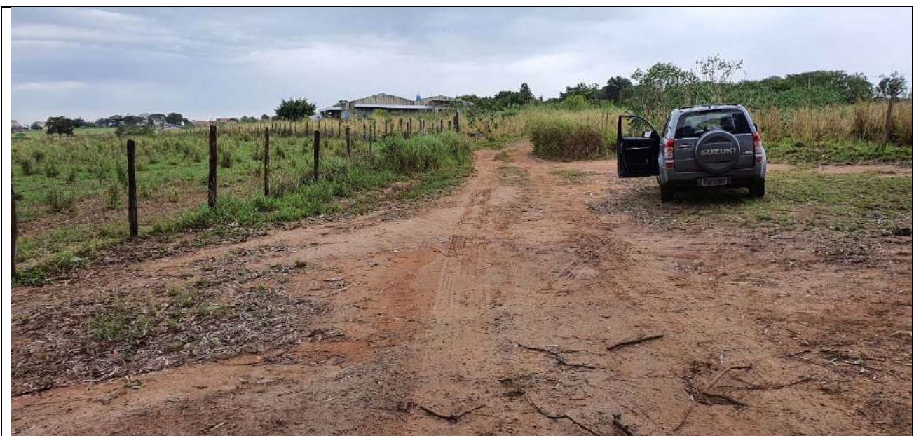
Foto 2: Aspecto da estrada de acesso à ETE.
