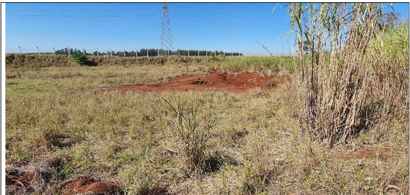
Foto 6: Mesma área. Notar ao centro pilhas de solo e, ao fundo, talude remanescente da escavação de solos, cerca delimitando a propriedade da Sabesp e torre de Linha de Alta Tensão.
