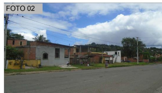
Ponto de ônibus com abrigo, localizado na BA-528 Estrada p/ Cotegipe, sem faixa de pedestre no local.
