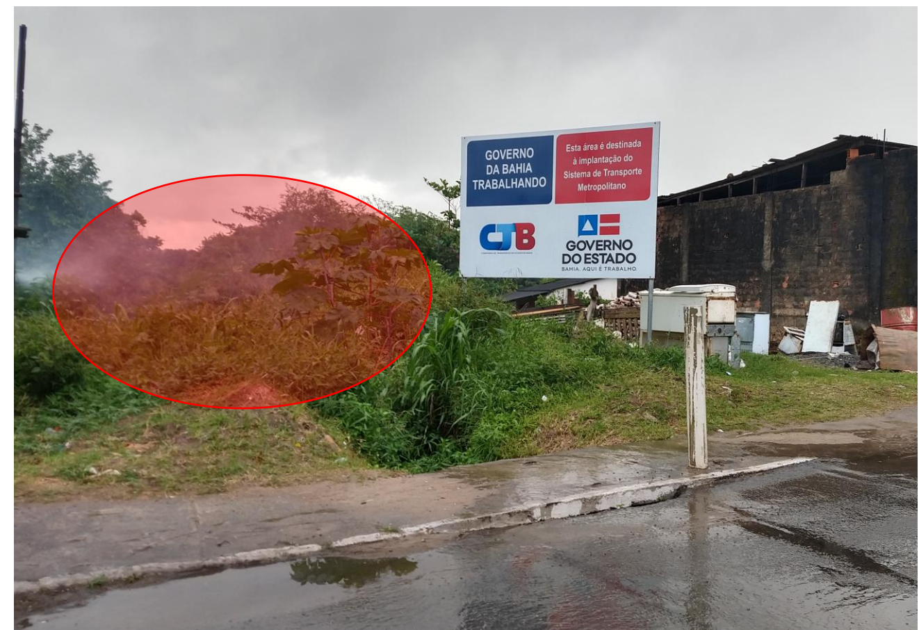
Figura 6.46 – Estação Ilha de São João: Região de Implantação
