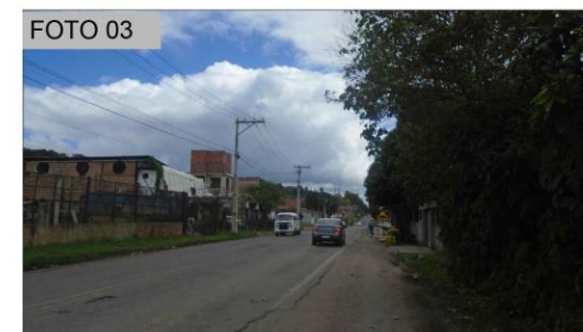
BA-528 Estrada p/ Cotegipe, placa de sinalização de quebra-mola e passeio inexistente.
