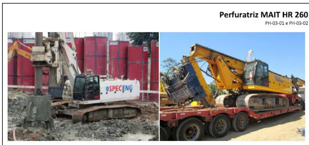
FIGURA 2-22 - Perfuratriz Utilizada na Execução da Estaca Escavada.
