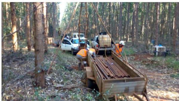
Figura 35 – Furo de sondagem SP02. Fonte: GEOTORK, 2018.
