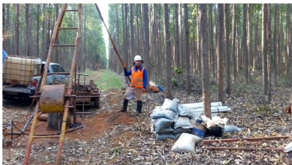
Figura 37 – Furo de sondagem SP04. Fonte: GEOTORK, 2018.
