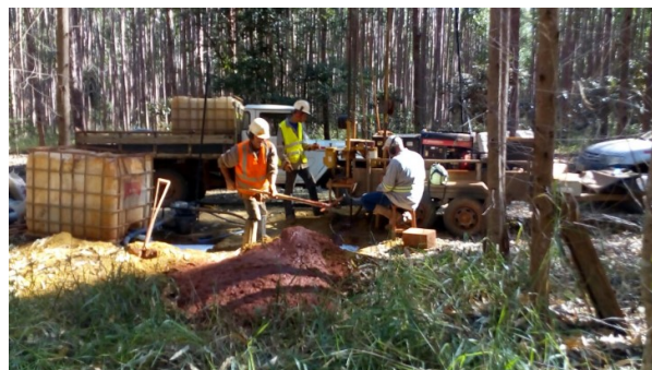
Figura 38 – Furo de sondagem SP05. Fonte: GEOTORK, 2018.
