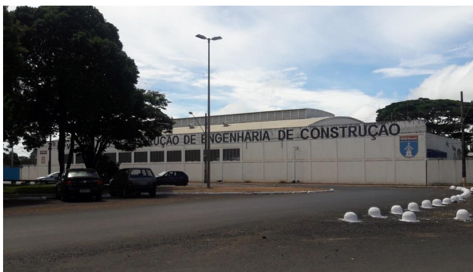
Figura 65 – Centro de Instrução de Engenharia de Construção do Exército em Araguari. Fonte: Pöyry Tecnologia (2018).
