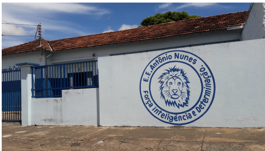
Figura 19 – Escola Estadual Antônio Nunes em Araguari. Fonte: Pöyry Tecnologia (2018).
