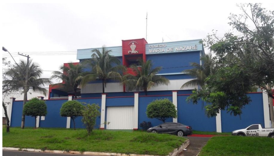
Figura 21 – Colégio Maria de Nazaré (Particular) em Uberlândia. Fonte: Pöyry Tecnologia (2018).
