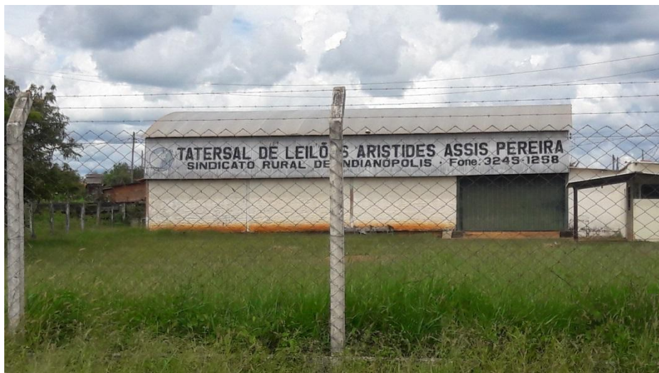
Figura 82 – Sindicato Rural de Indianópolis. Fonte: Pöyry Tecnologia (2018).
