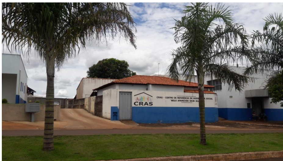
Figura 72 – Centro de Referência em Assistência Social (CRAS) em Indianópolis. Fonte: Pöyry Tecnologia (2018).
