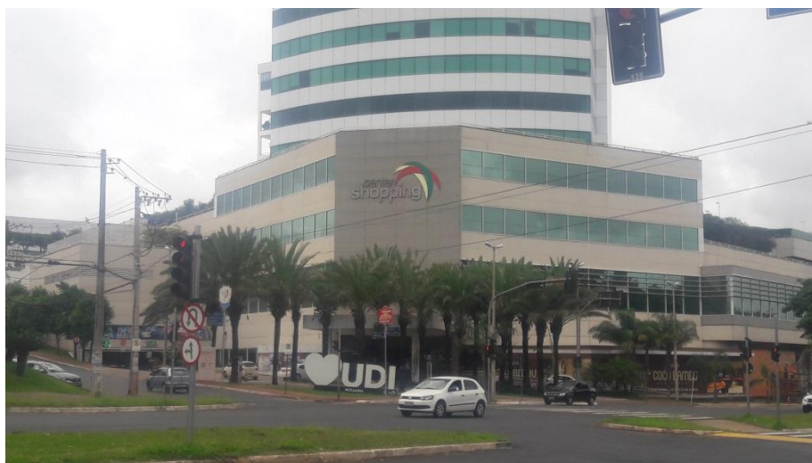
Figura 52 – Center Shopping em Uberlândia. Fonte: Pöyry Tecnologia (2018).
