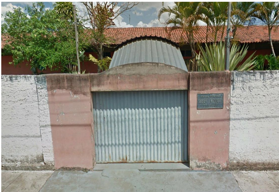
Figura 22 – Escola Estadual Robert Kenedy em Estrela do Sul. Fonte: Pöyry Tecnologia (2018).
