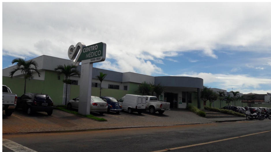
Figura 32 – Santa Casa em Araguari. Fonte: Pöyry Tecnologia (2018).
