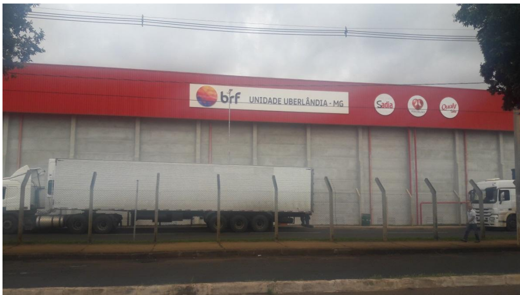
Figura 50 – Fábrica da BRF em Uberlândia. Fonte: Pöyry Tecnologia (2018).
