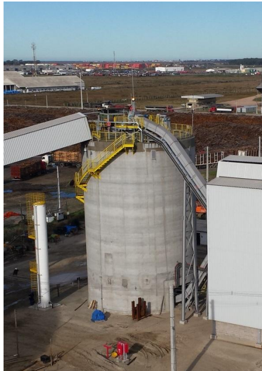
Figura 5 – Silo de cavacos. Fonte: Pöyry, 2018.
