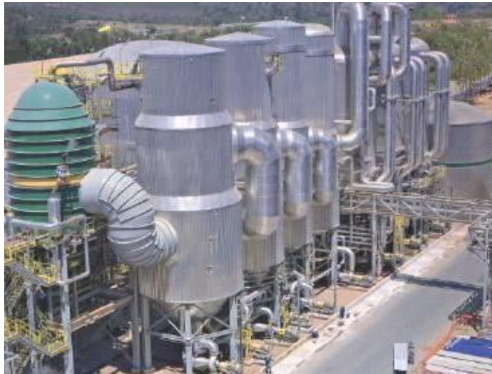
Figura 8 – Planta de Evaporação. Fonte: Pöyry, 2018.
