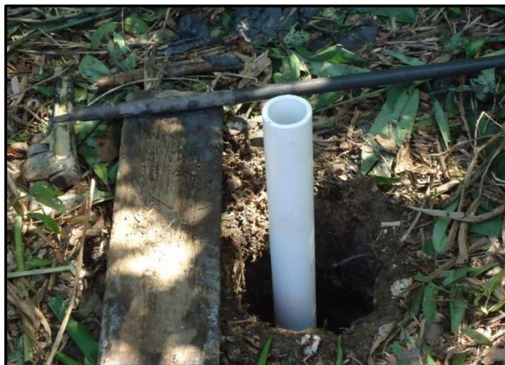
**Foto 02** – Revestimento com tubo de PVC de resina virgem em continuidade à coluna filtrante.
