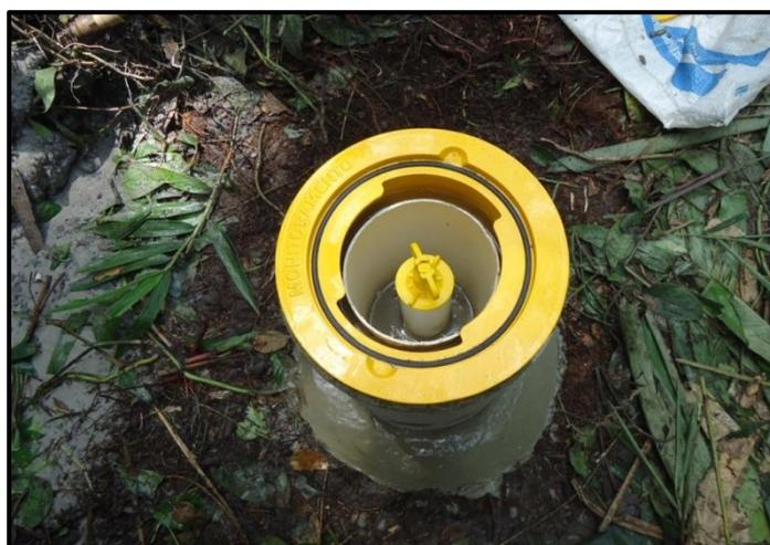
Foto 07 – Proteção sanitária com argamassa de cimento e tubo de concreto.
