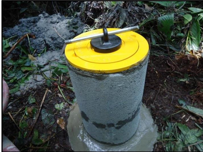
**Foto 08** – Poço finalizado com tampa de fechamento por pressão.
