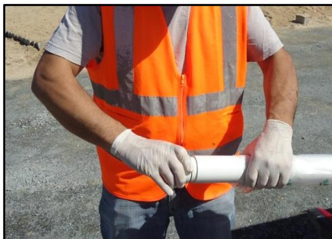
**Foto 03** – Filtros de 2,00 metros de comprimento e ranhuras homogêneas de 0,25 mm rosqueados no revestimento.
