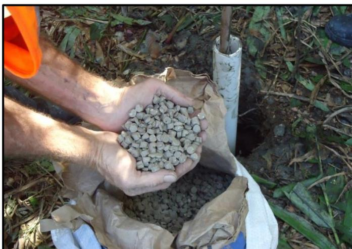
Foto 06 – Instalação do selo de bentonita acima do pré filtro.
