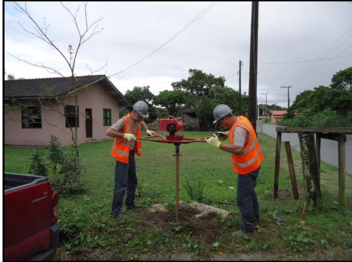
**Foto 01** – Trato mecanizado utilizado na perfuração dos poços de monitoramento.
