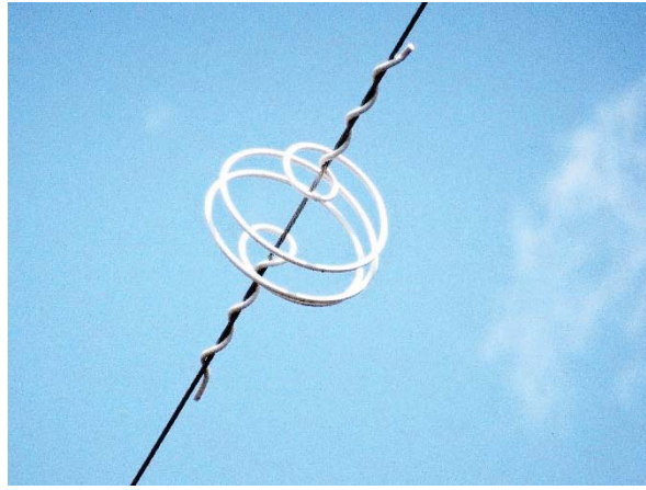
Figura 6.7-1 Disuasor de Vuelo de Aves Tipo Espiral
