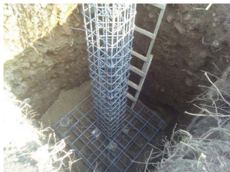
Ilustración 1: cimentación de una pata de una torre
