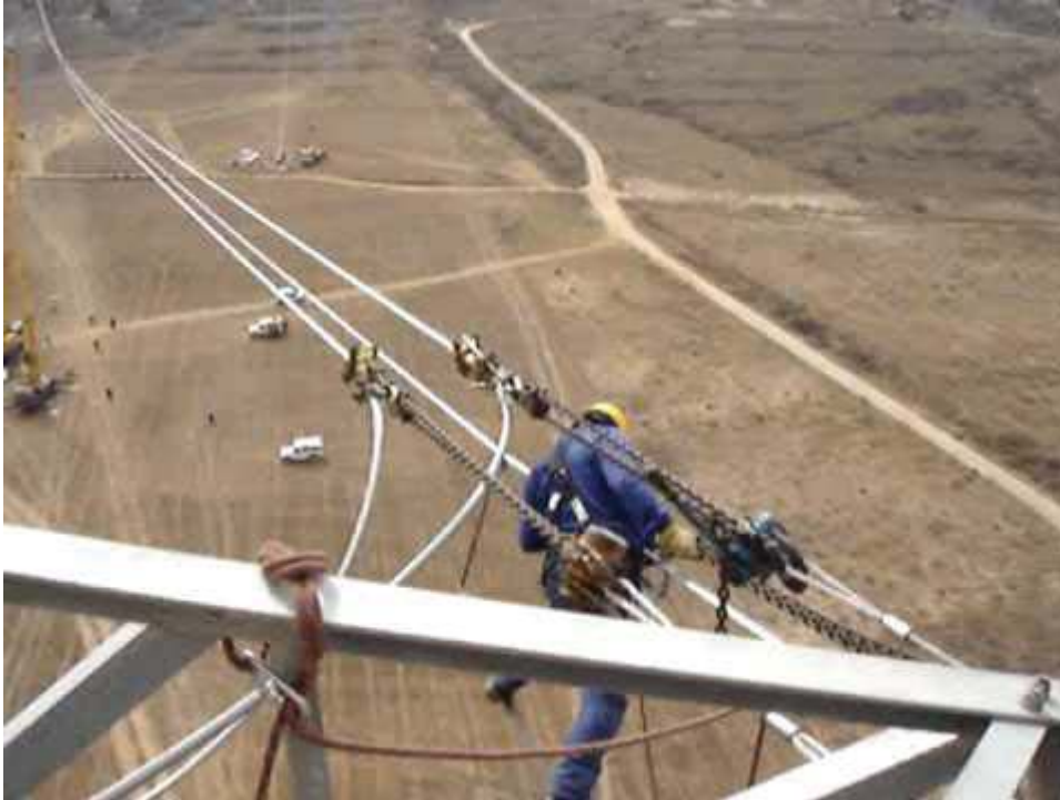
Ilustración 10: Personal técnico realizando actividad de tensado individual de cables en una torre.
