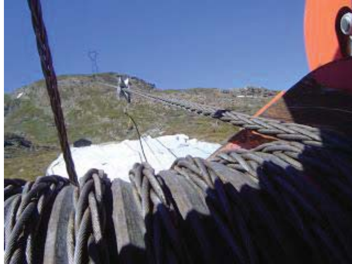
Ilustración 5: VISTA DE PROCESO DE LANZADO DE CABLE GUIA O CABLE PILOTO ENTRE LA MAQUINA Y TORRE.
