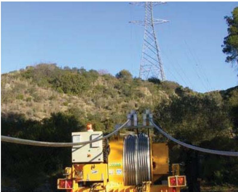
Ilustración 6: VISTA DE PROCESO DE TENDIDO DE CONDUCTOR ENTRE MAQUINA Y TORRE.
