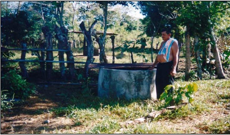
Pozo brocal encontrado en los tramos 1 al 3 del Proyecto. El nivel freático se encuentra a 5 m durante la estación seca. Chiriquí, febrero de 2003.
