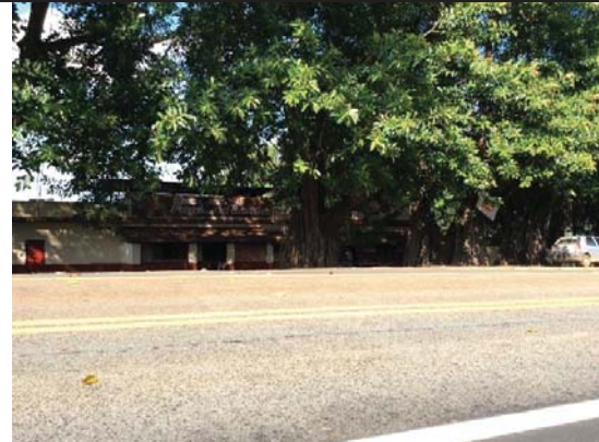
Visada 34S: Km 223+070. Vista geral da ADA Operação, local com comércio lindeiro à Faixa de Domínio, município de Formiga.
