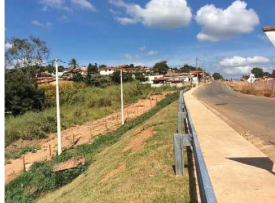
Visada 8S: km 72+880. Vista da ADA ITV 14 a 22, que se encontra em obras, município de Mateus Leme.
