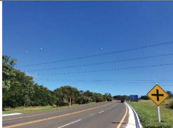
Visada 13: Km 638+500. Linhas de transmissão de Energia, município de São Sebastião do Paraíso.
