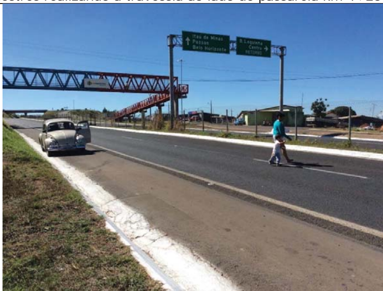
Foto 8: Pedestres realizando a travessia ao lado de passarela km 4+250 na BR-491.
