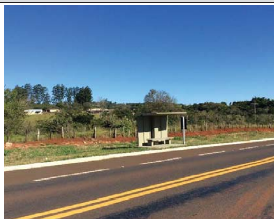
Foto 17: Vista de Ponto de ônibus, localizado no km 645+400, sentido oeste.
