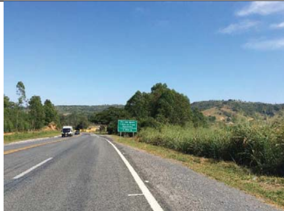
Foto 5: Trecho crítico de acidente próximo ao 163+800.
