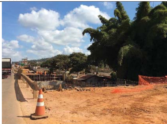
Visada 9S: km 73+650. Vista da ADA ITV 14 a 22, que se encontra em obras, município de Mateus Leme.
