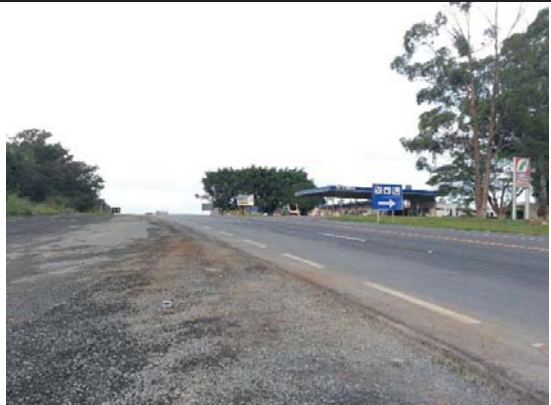
Visada 33S: km 215+000. Vista geral da ADA Operação, município de Córrego Fundo.
