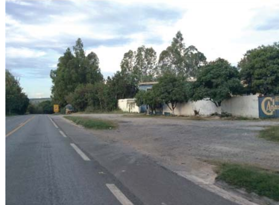
Visada 32S: km 212+600. Vista geral da ADA Operação. Ocupação lindeira à Faixa de Domínio, município de Córrego Fundo.
