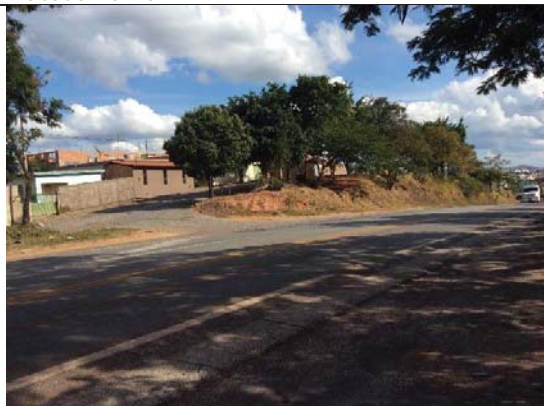
Visada 11S: Km 83+650. Vista da ADA ITV 26, não haverá intervenção em residências município de Itaúna.
