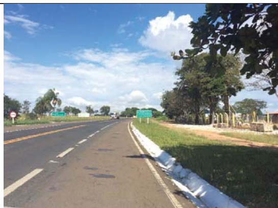
Visada 41S: 234+500. Vista geral da ADA Operação, município de Alpinópolis.
