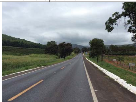
Visada 39S: km 286+900. Vista geral da ADA ITV 121, município de Capitólio.
