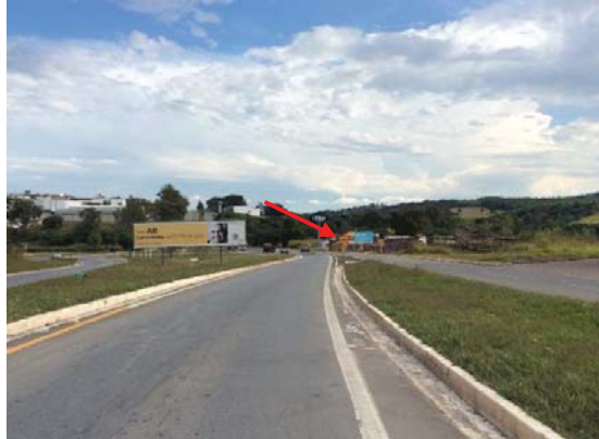
Visada 31S: Km 201+900. Vista geral da ADA ITV 81/81-A e 82 com ocupação irregular na Faixa de Domínio com atividades comerciais, município de Formiga.
