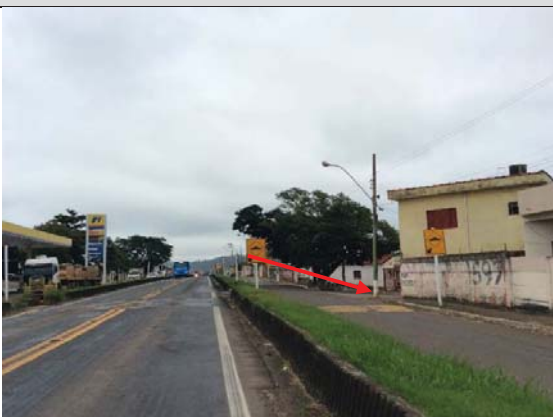
Foto 24: Área urbanizada do município de Itaú de Minas inserida em Faixa de Domínio, km 371+200.
