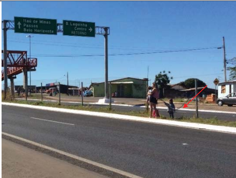
Foto 9: Pedestres realizando a travessia ao lado de passarela e detalhe de alambrado rebaixado para facilitar a travessia incorreta no km 4+250 na BR-491.
