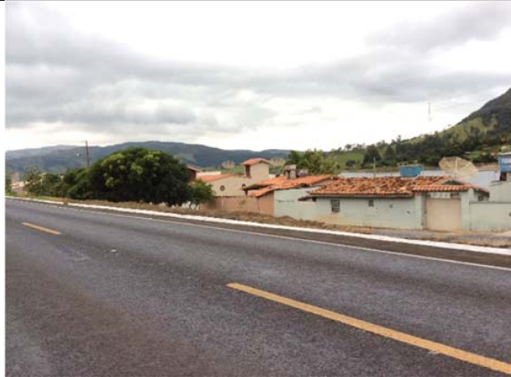
Visada 37: Km 293+000 oeste, MG-050. Área urbana do Município de Capitólio presente na AID.
