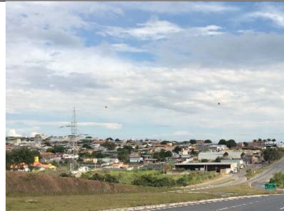
Visada 54: Km 201+900, leste MG-050. Vista geral da AID, onde é possível observar a área urbanizada do município de Formiga.
