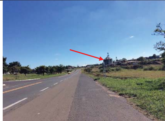
Visada 58S: km 0+000 BR-491. Vista geral da ADA ITV 173 a 178-B com atividades industriais, município de São Sebastião do Paraíso.
