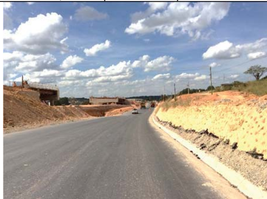
Visada 23S: Km 126+250. Vista da ADA ITV 54, 56 e 57, município de Divinópolis.
