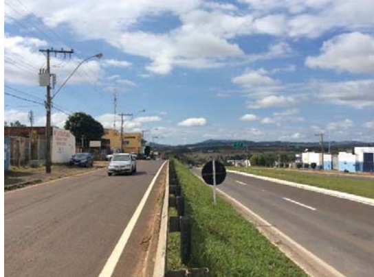
Visada 43S: Km 353+500 Vista geral da ADA Operação caracterizada pela área urbana lindeira à Faixa de Domínio, município de Passos.
