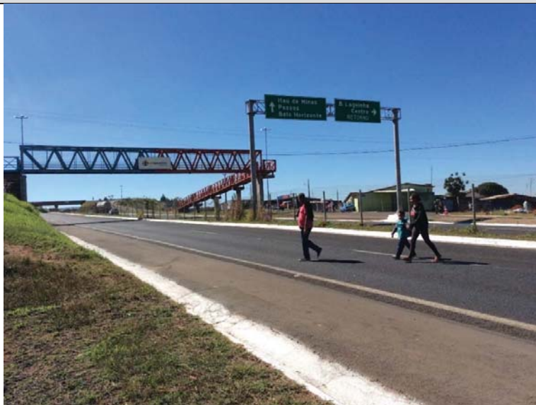
Foto 7: Pedestres realizando a travessia ao lado de passarela km 4+250 na BR-491.
