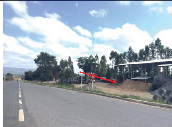
Foto 26: Ocupação da Faixa de Domínio por atividade industrial, município de Pimenta, km 240+430, sentido leste.
