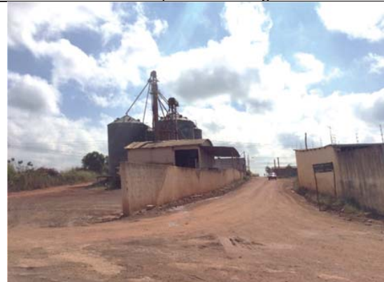
Visada 36S: Km 243+160. Vista geral da ADA ITV 103, onde área indústria está inserida município de Pimenta.
