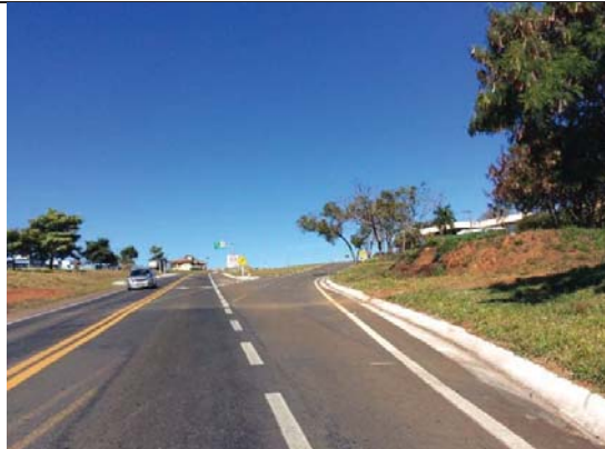
Visada 59S: km 01+640 BR-491. Vista geral da ADA ITV 173 a 178-B, município de São Sebastião do Paraíso.
