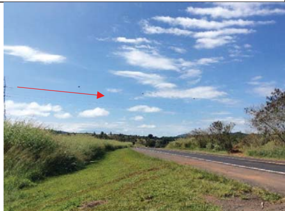
Visada 28: Km 349+600. Linhas de transmissão de energia, município de Passos.
