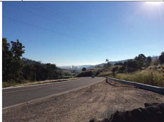
Visada 22: Km 377+300. Linhas de transmissão de Energia, município de Pratápolis.
