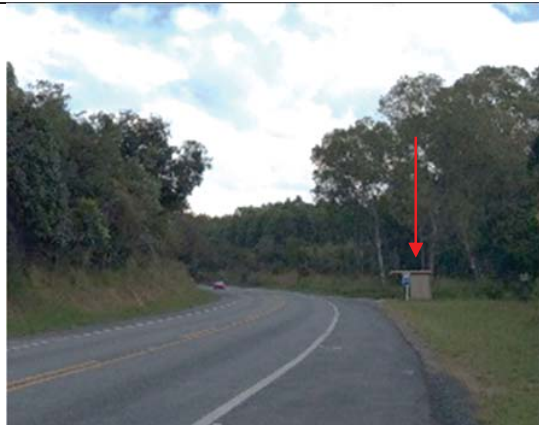
Foto 14: Vista de Ponto de ônibus sendo indicado pela seta, localizado no km 191+200, sentido leste.
