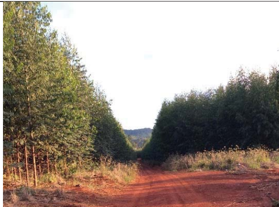
Visada 25: Km 372+000 oeste MG-050. Vista da AID com uso predominante de reflorestamento de eucalipto, município de Itaú de Minas.
