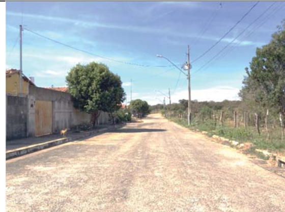
Visada 64: Km 120+000, leste MG-050. Área urbanizada do município de Divinópolis.
