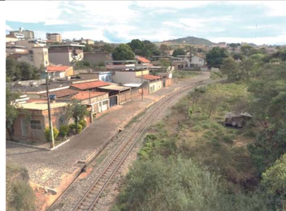
Visada 62: Km 128+640, leste MG-050. Área urbanizada do município de Divinópolis.
