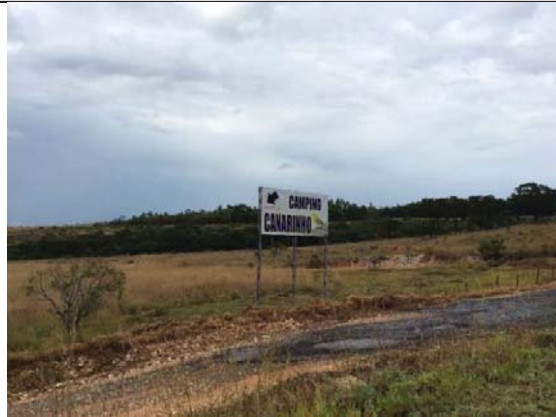
Visada 36: Km 299+900, oeste, MG-050. Vista de área utilizada para camping para turista, inserida na AID, município de Capitólio.
