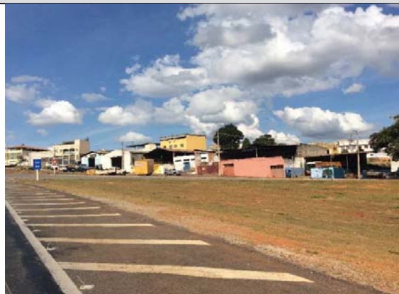
Foto 20: Área urbana do município de Itaúna lindeira à Faixa de Domínio, km 86+000.
