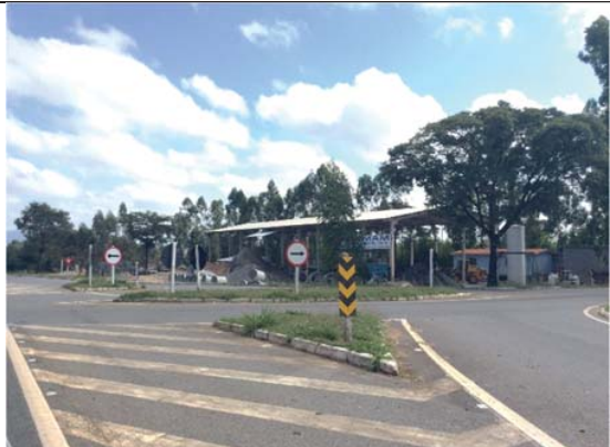
Visada 35S: Km 240+300. Vista geral da ADA Operação onde parte da área industrial ocupa a Faixa de Domínio, município de Pimenta.
