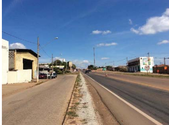
Visada 7S: km 68+830. Vista da ADA ITV 14 a 22, que se encontra em obras, município de Mateus.
