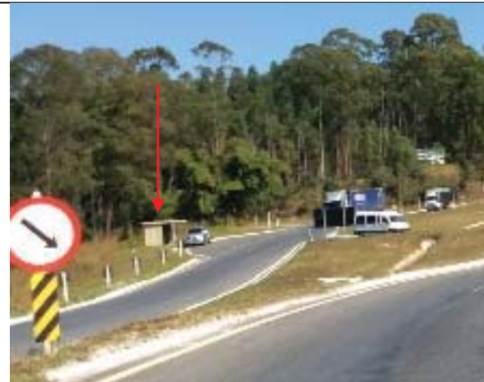
Foto 13: Vista de Ponto de ônibus sendo indicado pela seta, localizado no km 164+000, sentido oeste.
