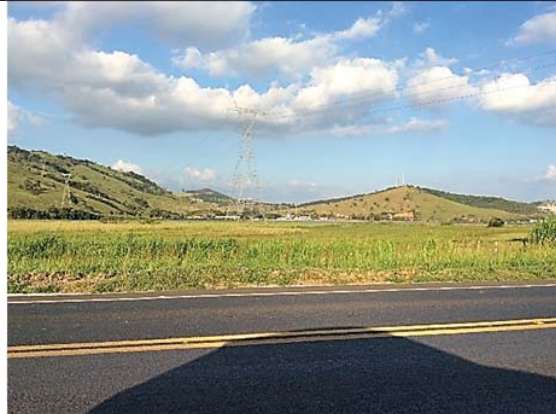
Visada 40: Km 285+180. Linhas de transmissão de energia, município de Capitólio.
