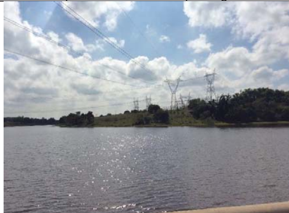
Visada 49: Km 242+600. Linhas de transmissão de energia, município de Pimenta.
