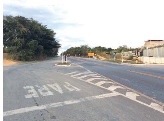
Visada 14S: Km 110+300. Vista da ADA ITV 45-A, não haverá intervenção em residências, município de Carmo do Cajuru.
