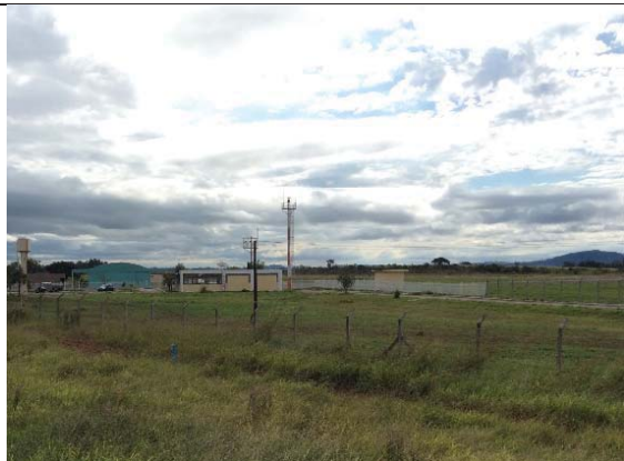
Visada 27: Km 360+200, leste MG-050. Vista de area com características urbanas na AID, município de Passos.
