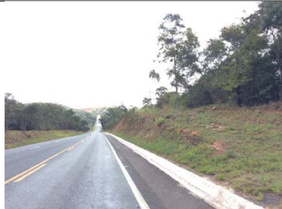
Foto 6: Trecho crítico de acidente próximo ao 253+830.
