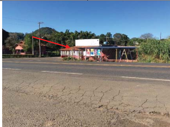
Foto 27: Ocupação irregular de comércio na Faixa de Domínio município de Pratópolis, km 383+760, sentido oeste.
