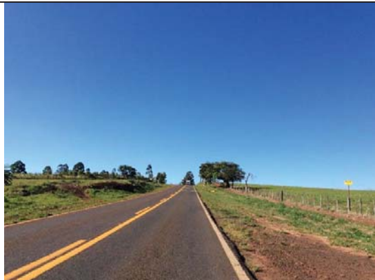
Visada 63S: km 650+600 Vista geral da ADA ITV 189, município de São Sebastião do Paraíso.
