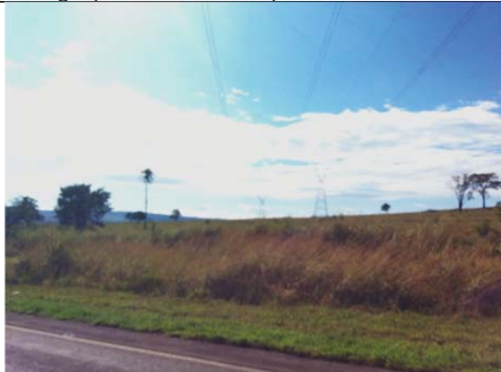
Visada 31: Km 327+000. Linhas de transmissão de energia, município de Alpinópolis.
