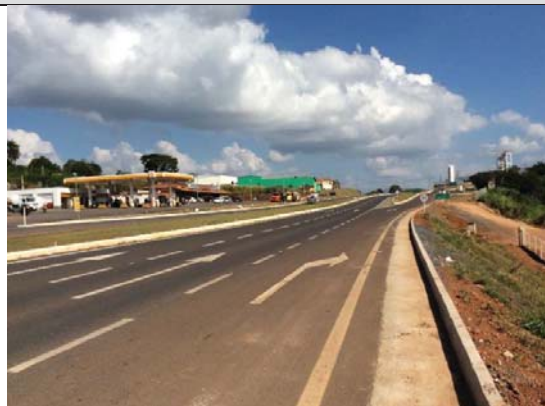
Visada 37S: km 263+800. Vista geral da ADA ITV 113, município de Piumhi.
