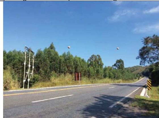
Visada 58: Km 164+650. Linhas de transmissão de energia, município Pedra do Indaiá.
