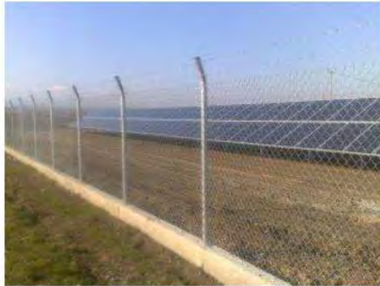
Figura II.7. Vallado del proyecto.
