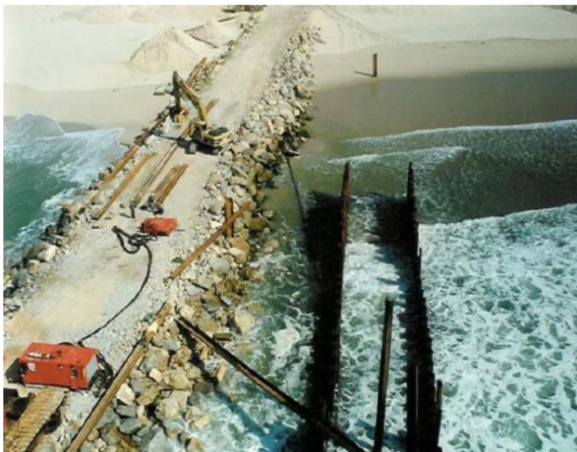
Figura 5-12: Exemplo de uma das alternativas que poderão ser adotadas para a implantação da adutora e emissário no trecho inicial em mar
