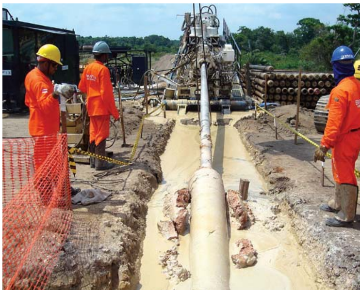
Foto 3-5: Instalação de tubulação por Perfuração Direcional Horizontal.
