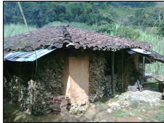
Foto No. 10 Vista exterior trapiche.
