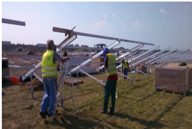
Figura 14. Montagem das estruturas que apoia os módulos fotovoltaicos.
