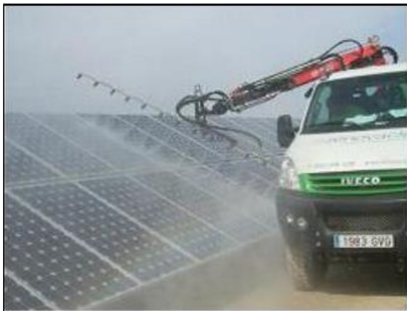
Figura 71. Limpeza das placas.
