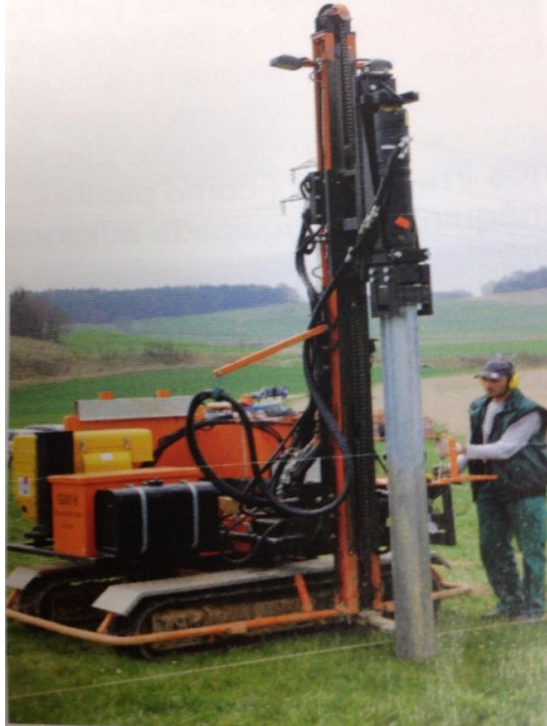
Figura 13. Máquina hidráulica de fixação dos módulos.
