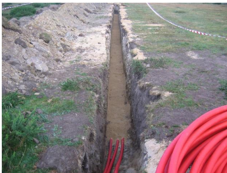
Figura 24. Abertura das valas para execução da passagem dos cabos.
