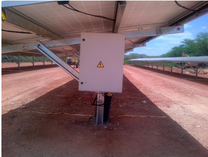
Figura 23. Caixa de junção C.C.
