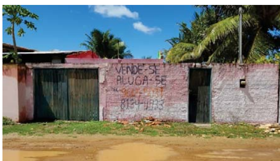
Foto 7.3-1: Casa 2 Antes Da Desocupação
