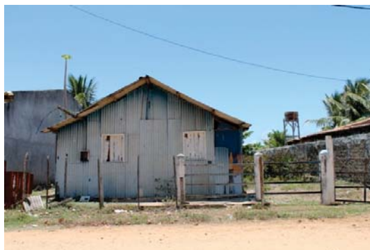
Foto 7.5-1: Casa 5 Que Atualmente Encontra-Se Demolida
