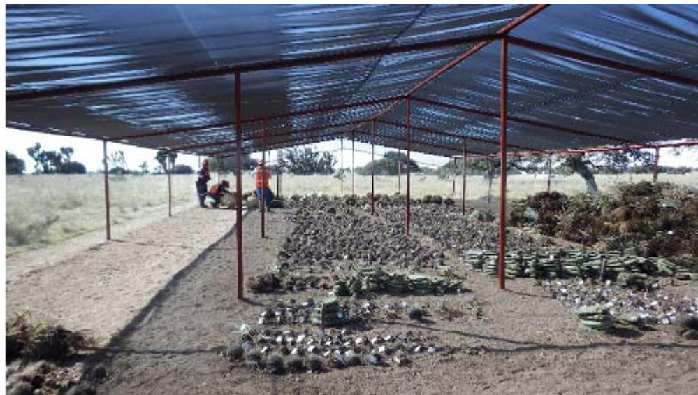
Figura 2.15 Ejemplo de estructura tipo vivero que será construida dentro del Área de Cuarentena y Reubicación de Vegetación rescatada, para el mantenimiento previo trasplante.
