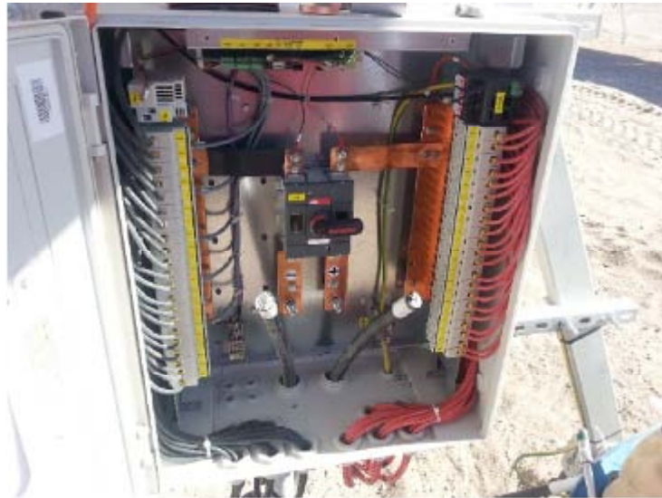
Figura 2.6 Caja de combinación típica.
