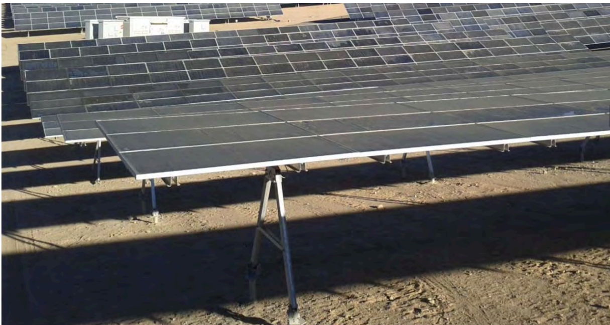
Figura 2.29 Instalación de seguidores (trackers) a una distancia adecuada para evitar el efecto sombra sobre los mismos módulos durante el día.
