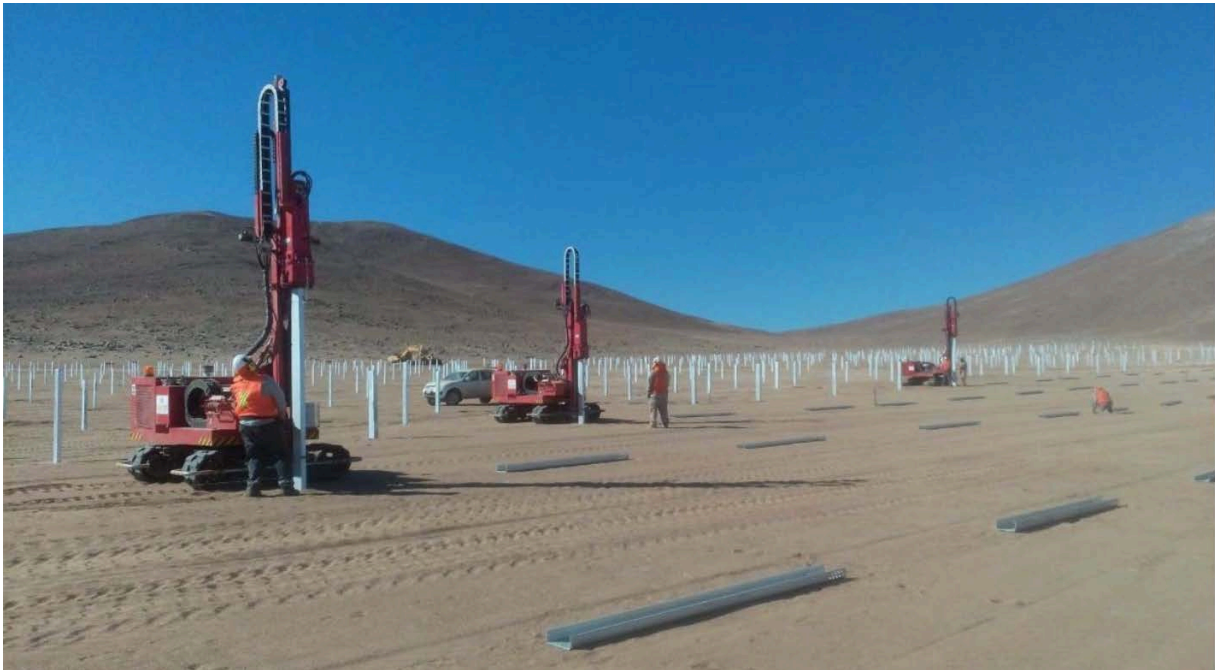
Figura 2.26 Instalación de estructuras de soporte de los módulos fotovoltaicos sobre la superficie que ha sido objeto del desmonte y despalme, así como después de su nivelación.
