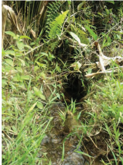
Fotografía 9 Quebrada No 6 – Vereda Campo Alegre
